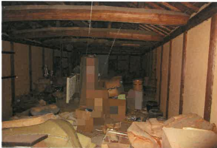
写真8 物件4主建物・2階倉庫
