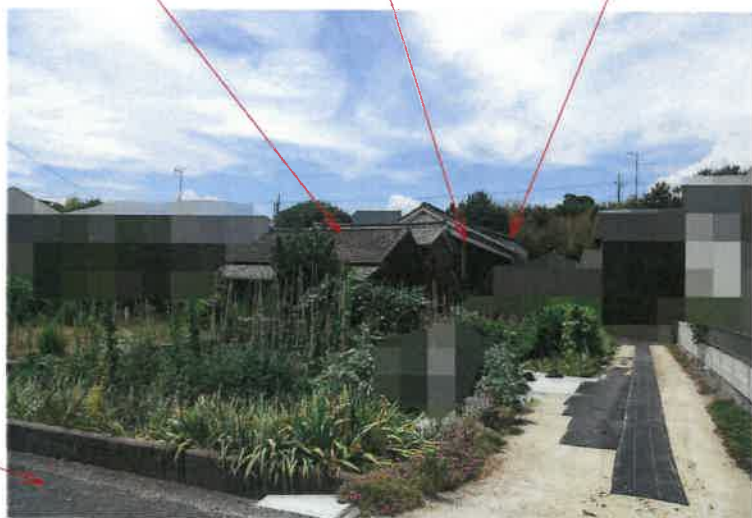
写真3 物件4附属建物 物件4主建物 物件5建物
