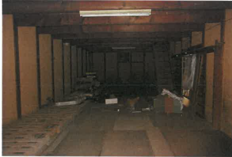
写真7 物件4主建物・1階倉庫
