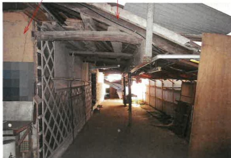
物件4主建物 下屋状物置
