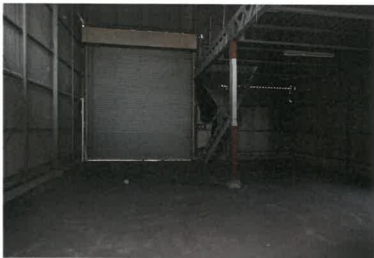
写真12 物件5建物・1階倉庫
