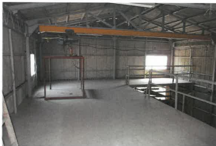
写真13 物件5建物・2階倉庫
