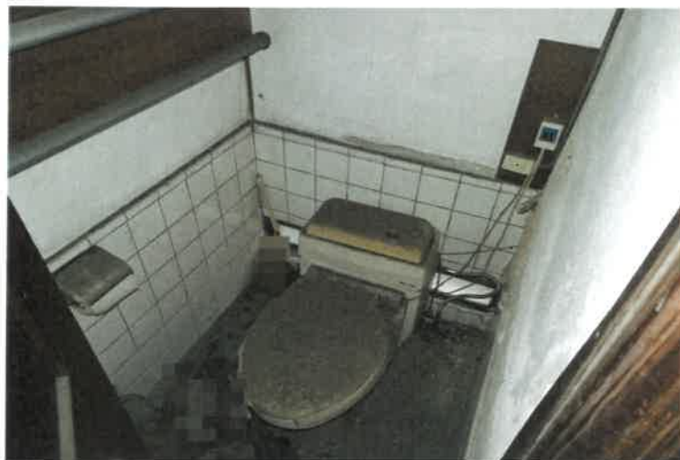
写真 3 0 物件 4 の建物内の状況
