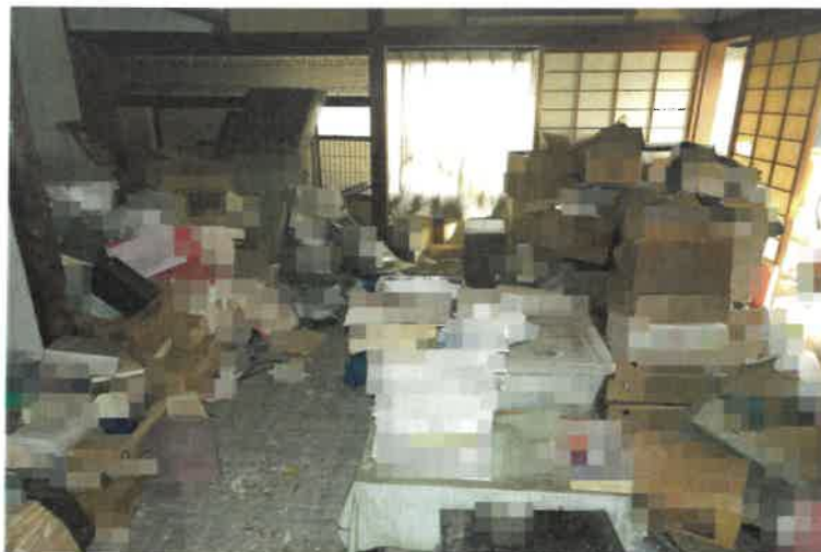
写真 3 7 物件 4 の建物内の状況
