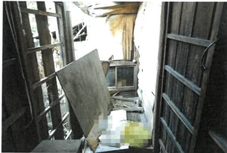
写真26 物件3, 4建物間の通路部分の状況
