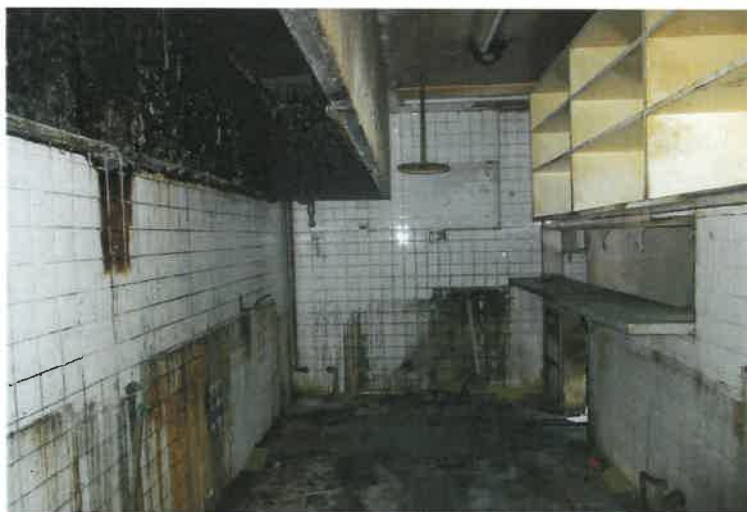
写真11 物件2建物・東側厨房
