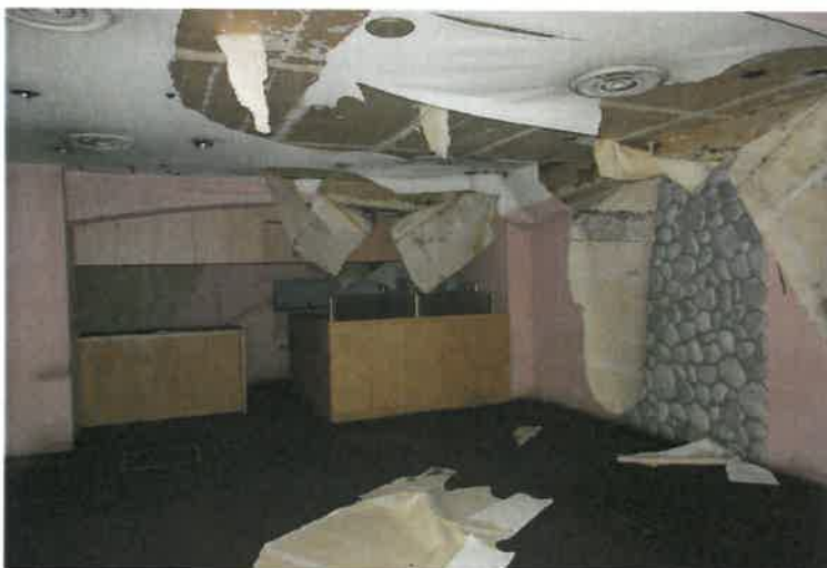
写真8 物件1、2建物・店舗部分
