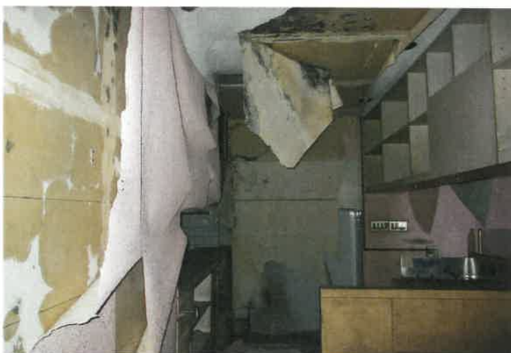
写真9 物件2建物・西側厨房
