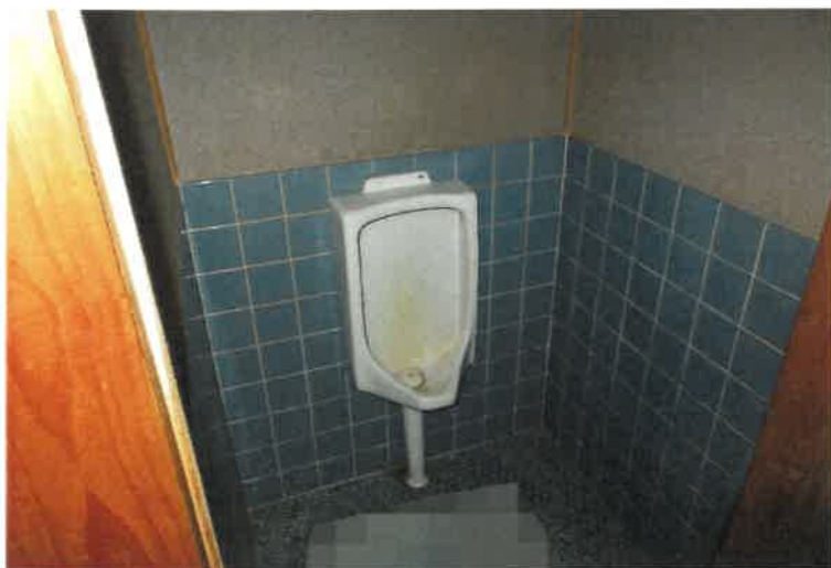
写真6 主建物・1階男性用トイレ
