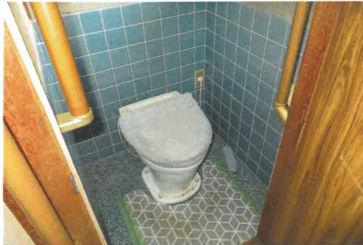
写真7 主建物・1階トイレ
