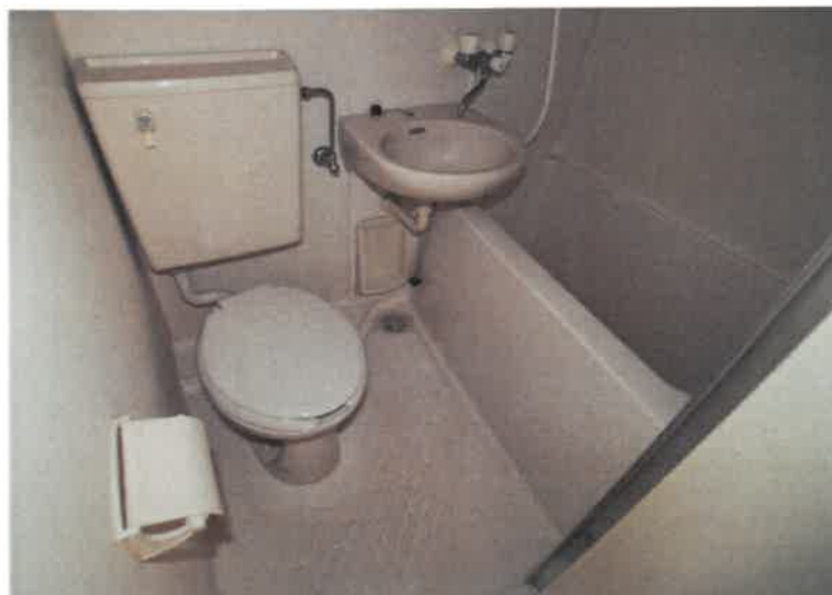
写真12 (2階202号室浴室・トイレ)
