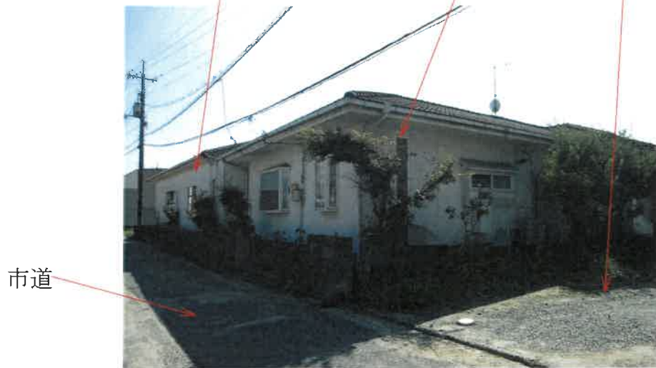
写真5 目的外建物（増築部分） 目的外建物 物件2土地
