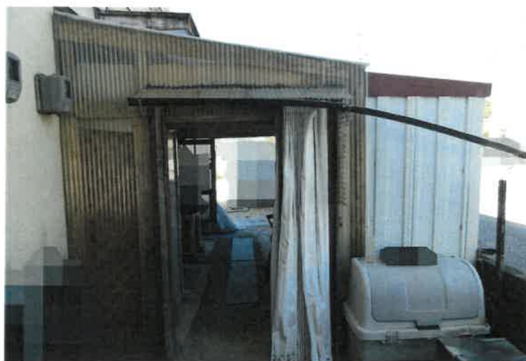
写真4 5 物件3建物・4号室・玄関前下屋状物置
