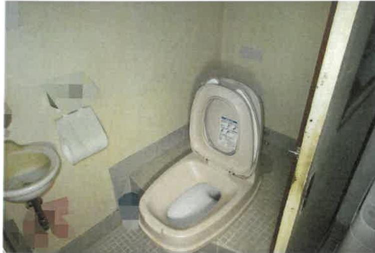
写真37 物件3建物・4号室・1階トイレ
