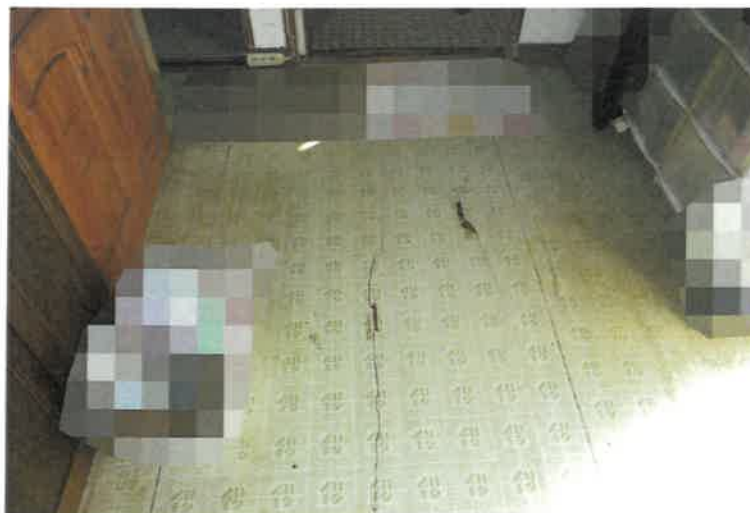
写真40 物件3建物・4号室・1階DK（床面）
