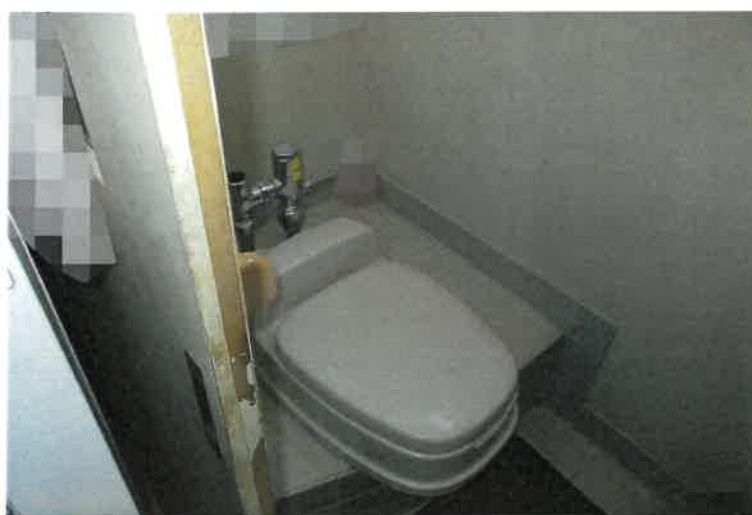
写真8 物件3建物・1号室・1階トイレ
