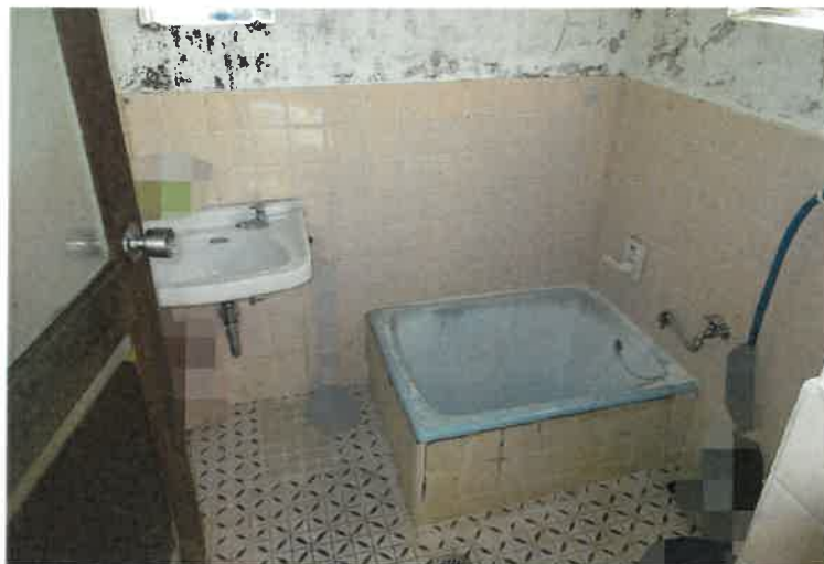
写真38 物件3建物・4号室・1階浴室
