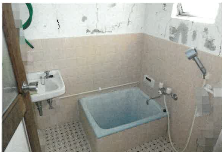
写真21 物件3建物・2号室・1階浴室
