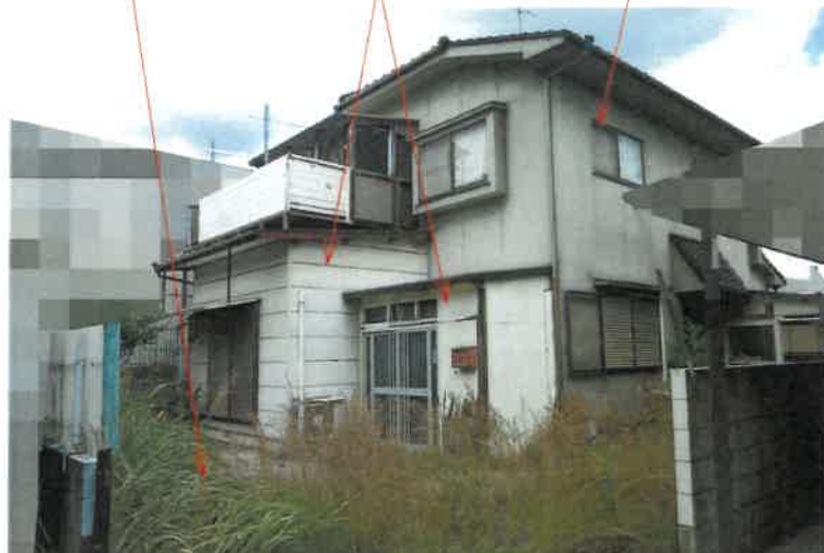
写真1 物件1土地 未登記増築部分 物件2建物
