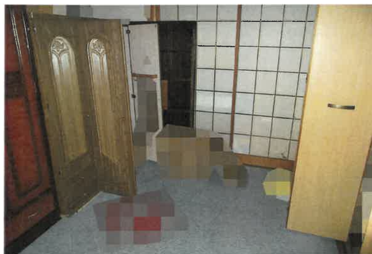
写真18 1階和室約4畳 (未登記増築部分)
