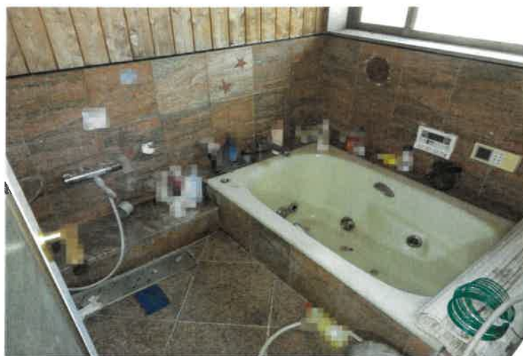
写真8 物件3の建物内の状況
