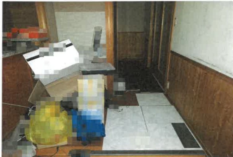
写真5 物件3の建物内の状況
