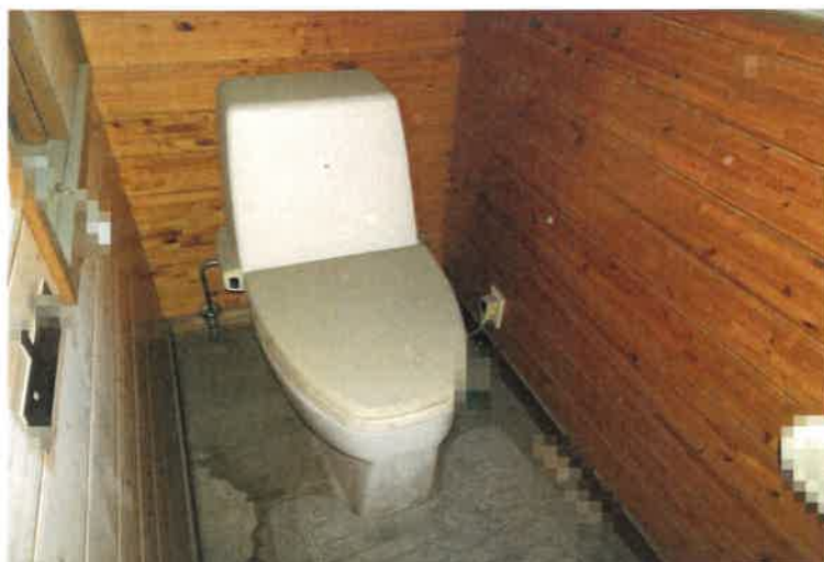
写真15 物件3の建物内の状況
