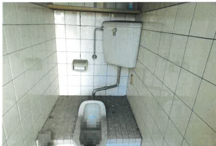
写真21 物件4の建物内の状況
