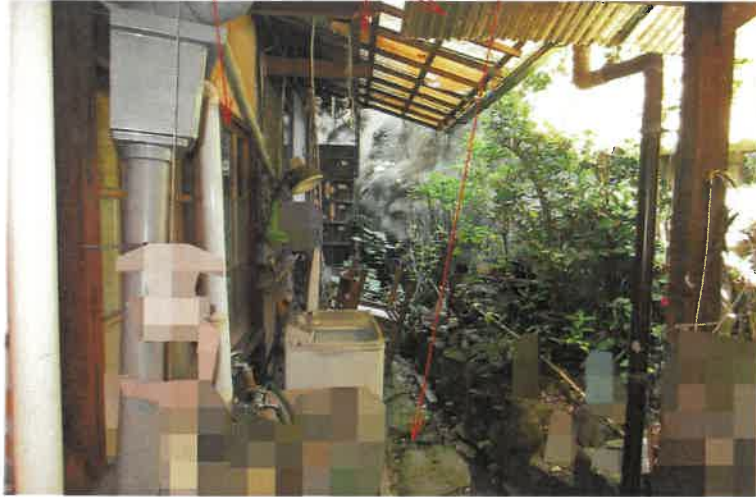
写真4 物件6主建物 下屋 物件3土地
