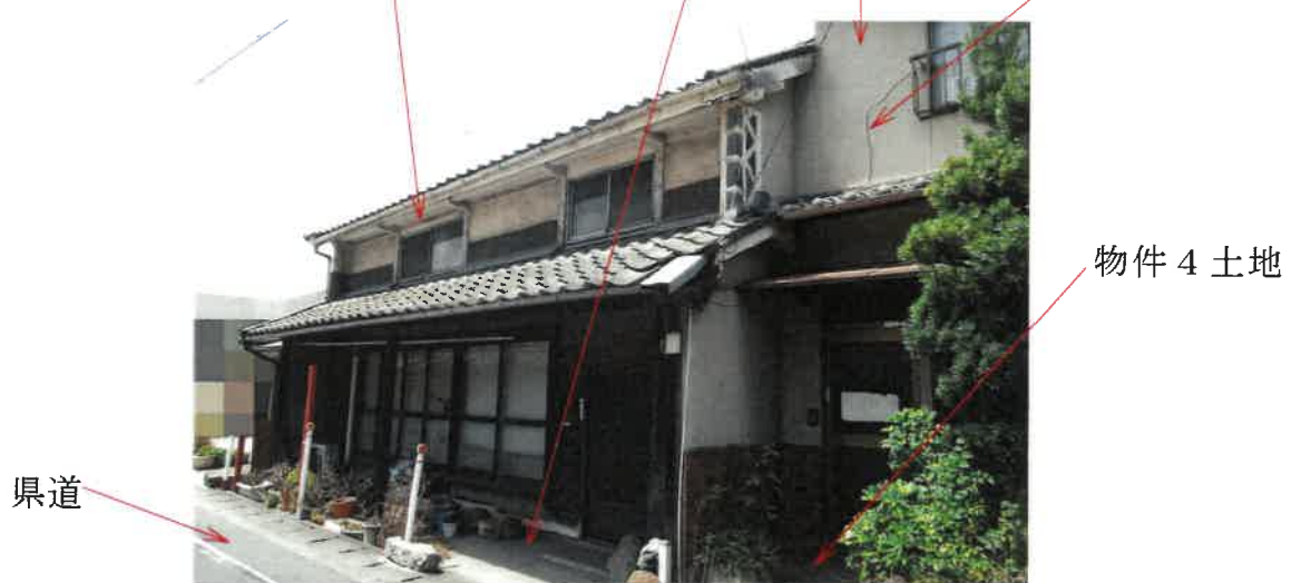
写真3 物件6 附属建物符号1 物件3 土地 物件7 建物 ひび割れ
