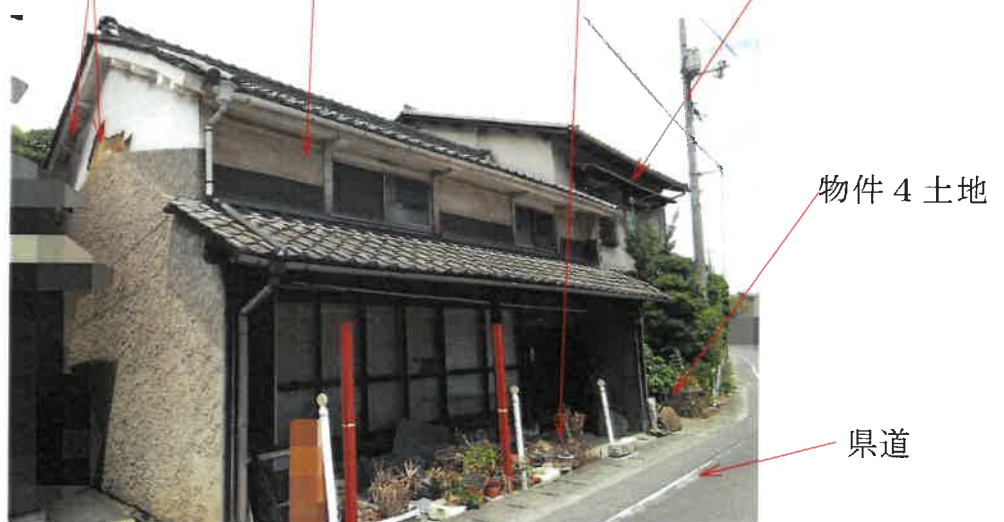
写真2 剥がれ 物件6 附属建物符号1 物件3 土地 物件7 建物
