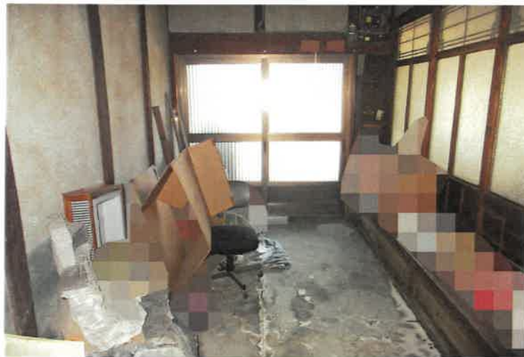
写真14 物件6附属建物符号1・1階土間
