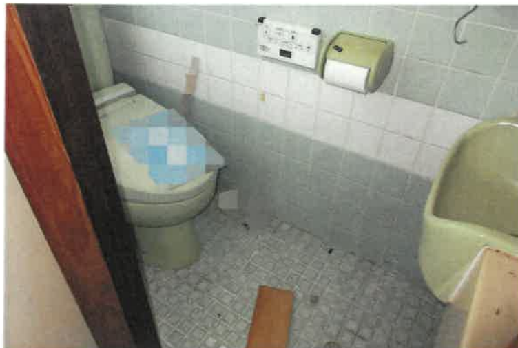
写真28 物件7建物・2階トイレ（未登記増築部分）
