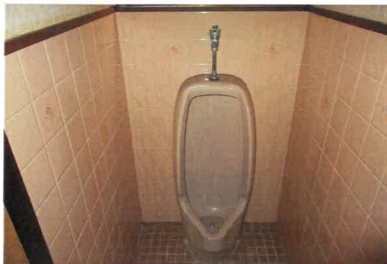
写真6 物件6主建物・1階男性用トイレ
