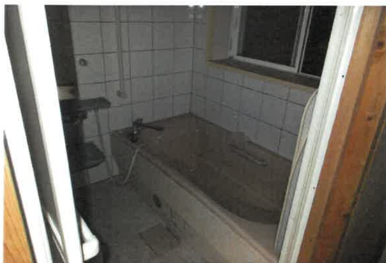
写真8 物件6主建物・1階浴室
