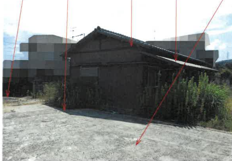
写真2 市道 物件1土地 物件3建物 下屋 基礎跡箇所
