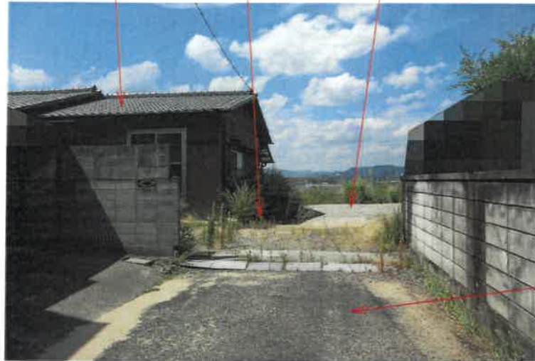
写真1 物件3建物 物件1土地 基礎跡箇所
