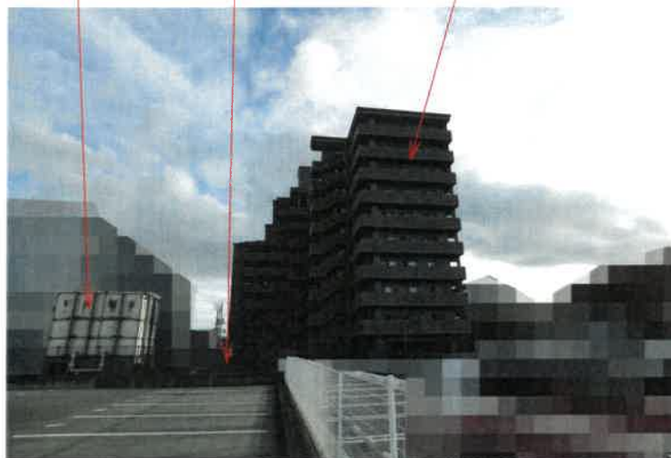
写真3 受水槽 符号1の土地 本件一棟の建物
