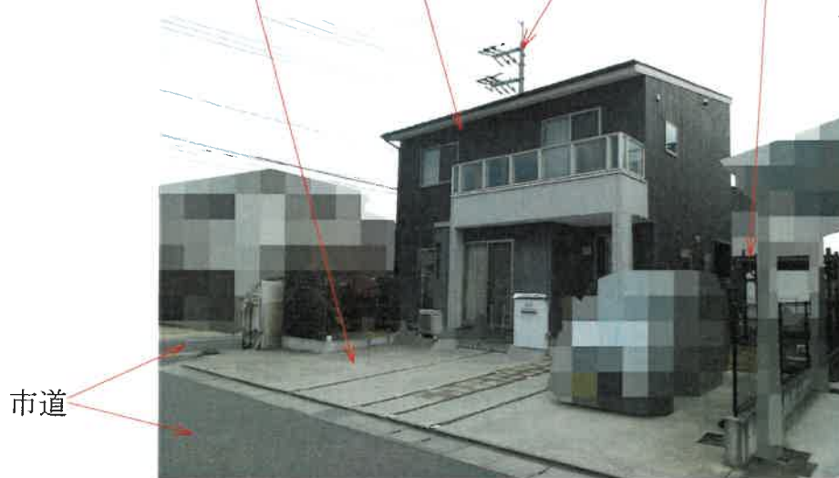
写真2 物件1土地 物件2建物 電柱 自転車置場
