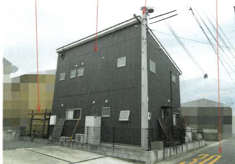
写真3 自転車置場 物件2建物 電柱 市道
