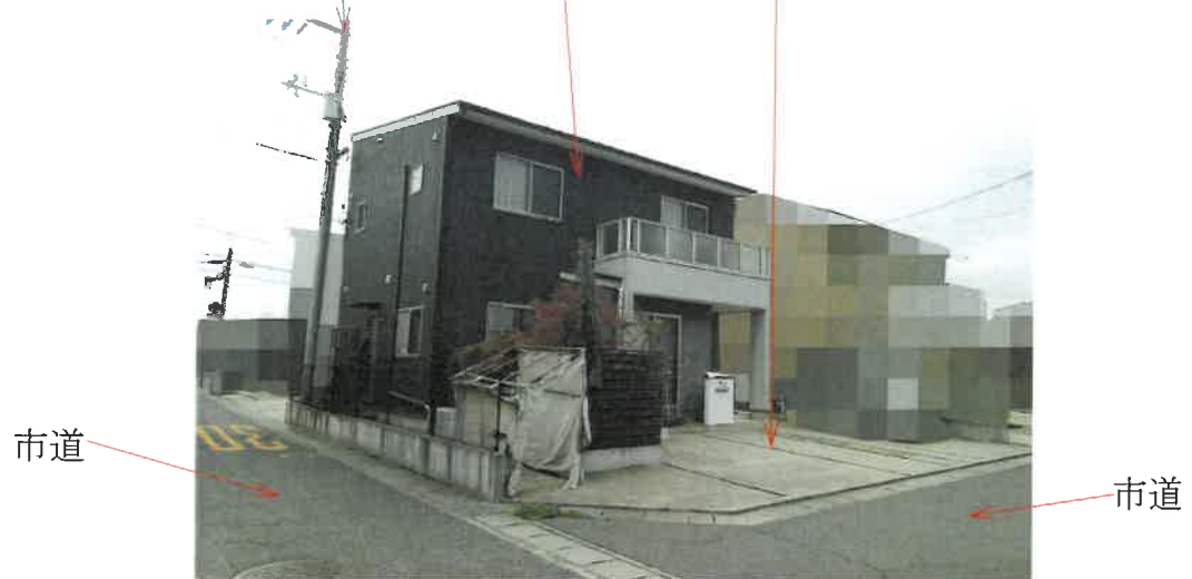
写真1 電柱 物件2建物 物件1土地
