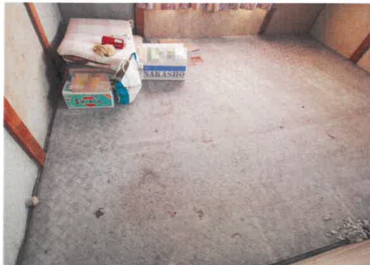
写真9 (主建物2階南側和室6帖)
