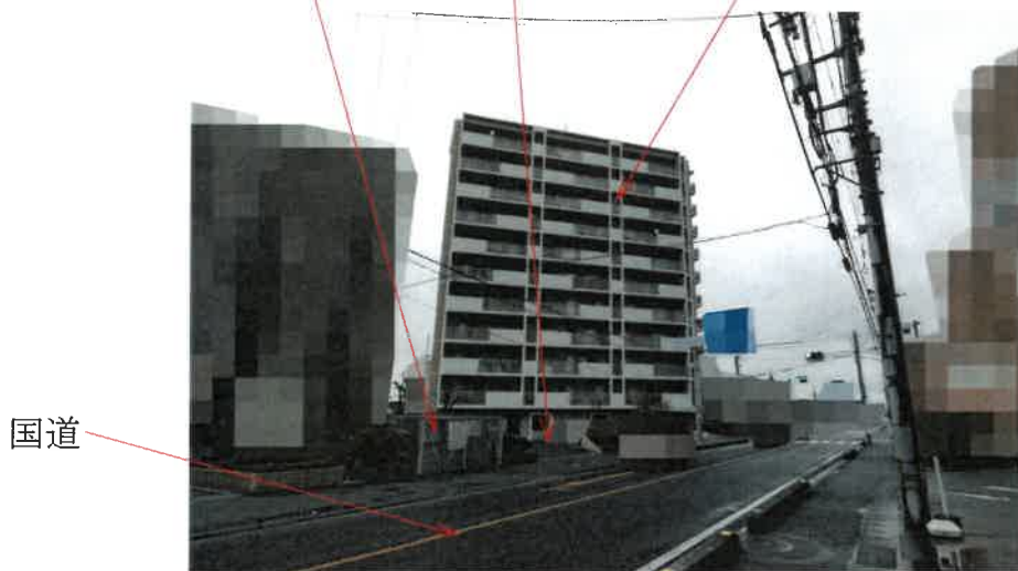
写真5 ゴミステーション 符号1の土地 本件一棟の建物
