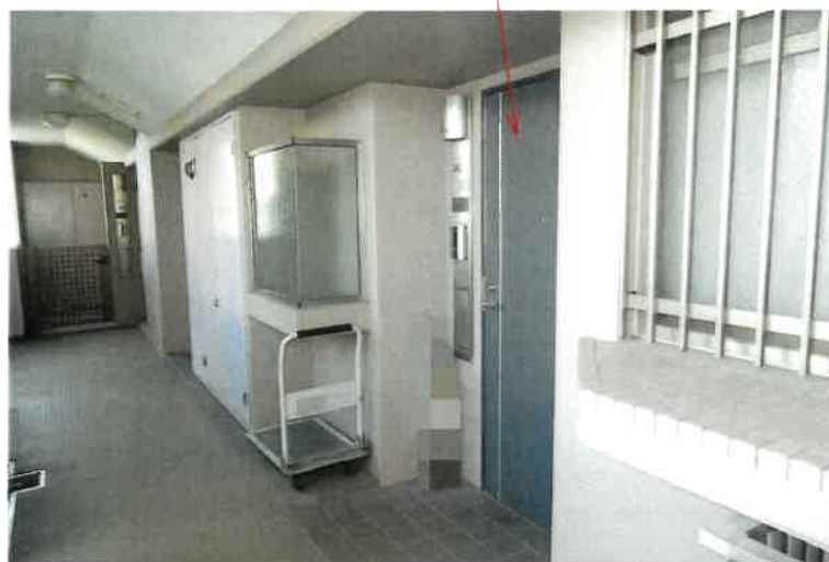
写真6 物件1建物 玄関扉
