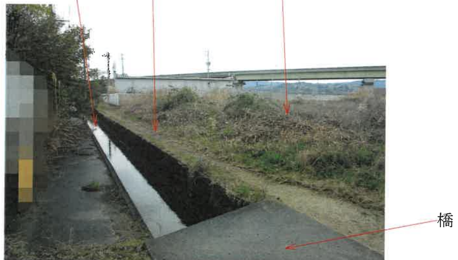
写真5 水路 市道 物件1土地
