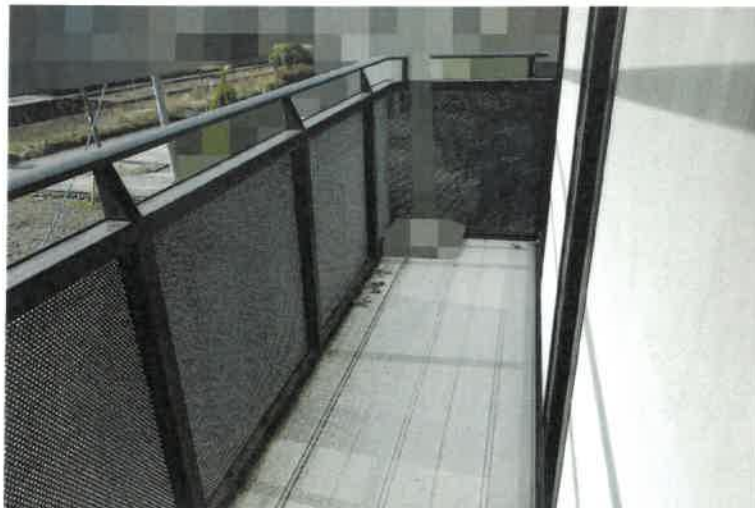
写真34 物件4建物・2階バルコニー
