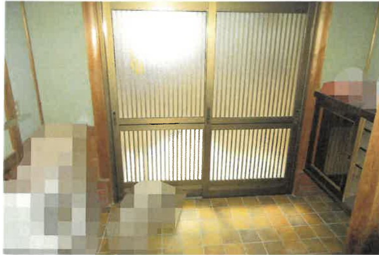
写真7 物件3建物・1階玄関
