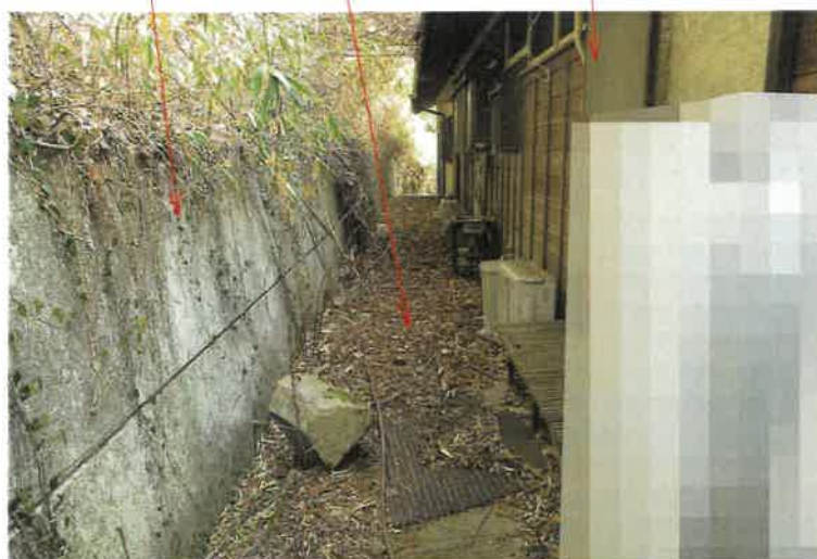
写真6 擁壁 物件1土地 物件3建物
