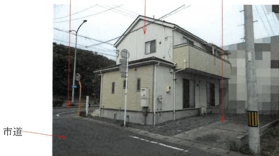
写真2 県道 物件2建物 物件1土地
