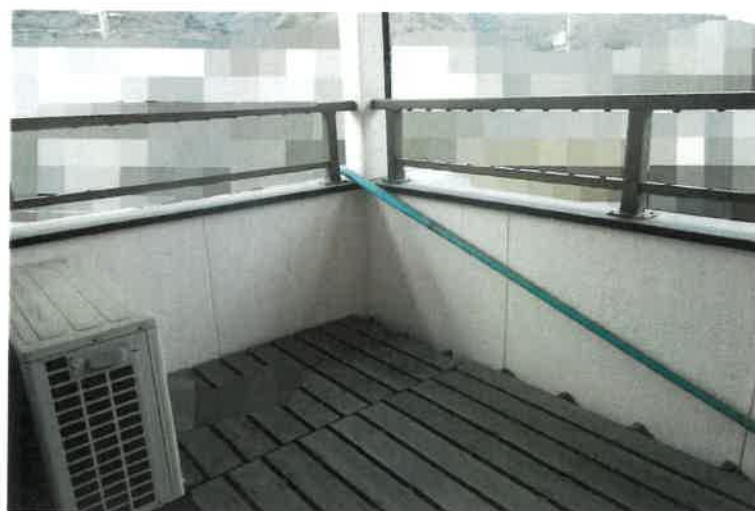
写真18 2階南西側ベランダ
