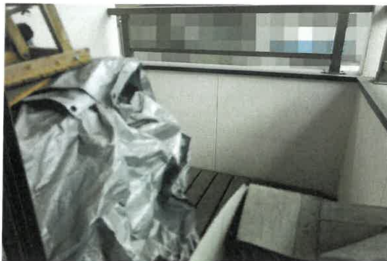
写真19 2階北東側ベランダ
