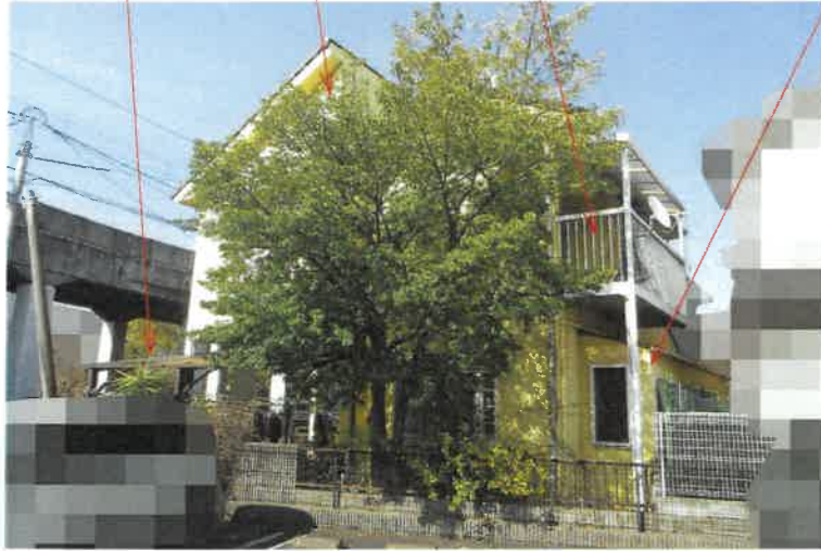
写真4 カポート 物件3建物 2階バルコニー 未登記増築部分(1階)
