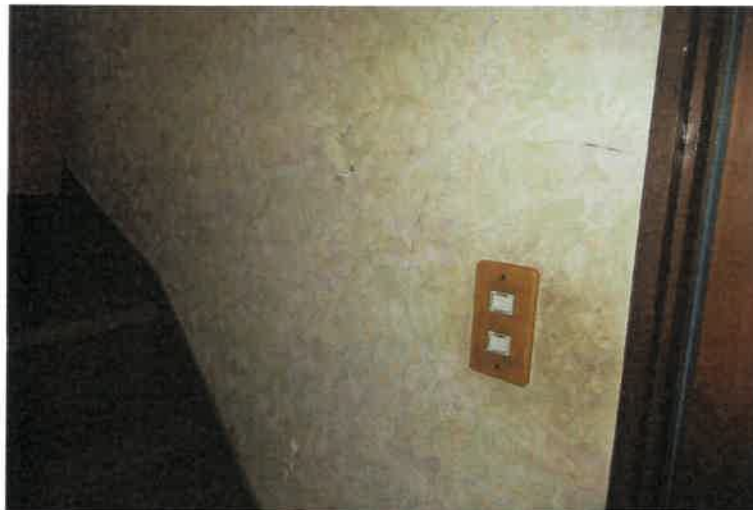
写真14 1階階段（壁部分）
