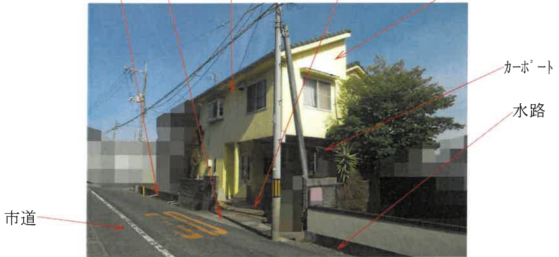
写真1 水路 床版 物件3建物 物件1、2土地 未登記増築部分（2階）
