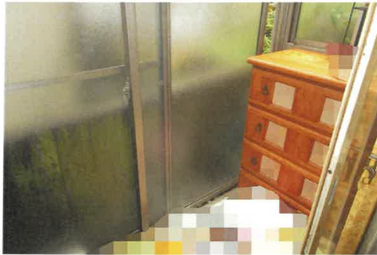
写真13 1階サンルーム（未登記増築部分）
