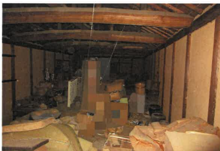
写真8 物件4主建物・2階倉庫
