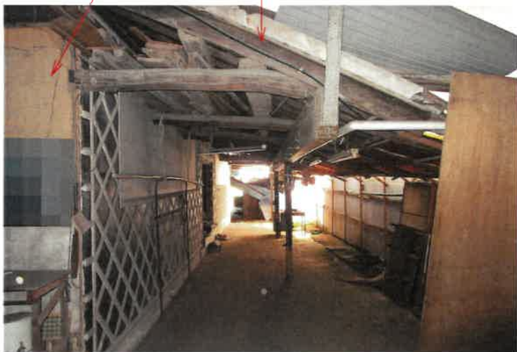
写真6 物件4主建物 下屋状物置
