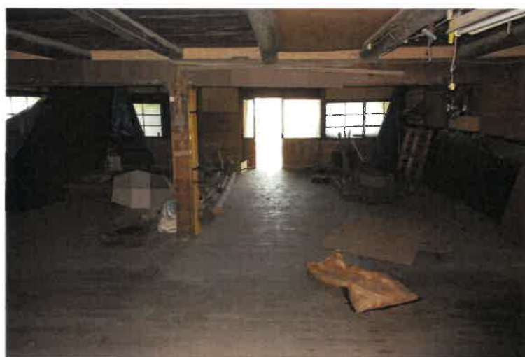
写真9 物件4附属建物・作業場
