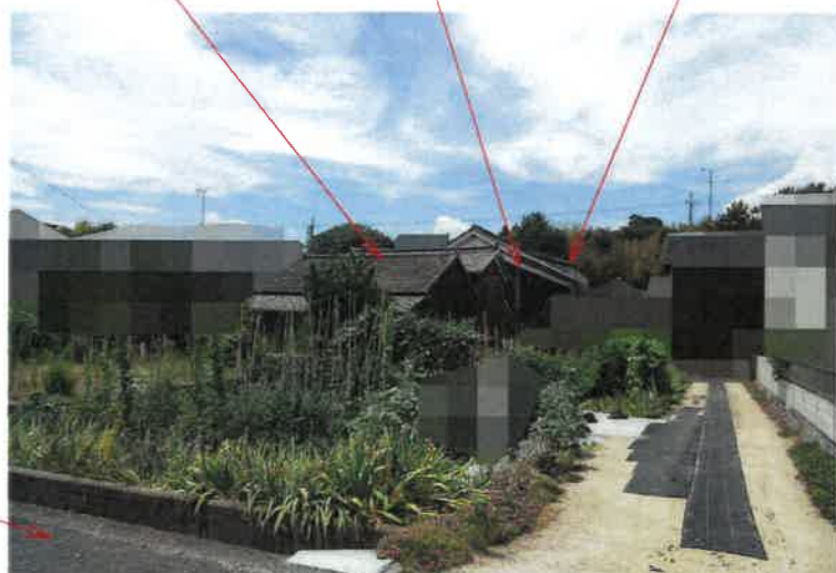
写真3 物件4附属建物 物件4主建物 物件5建物
