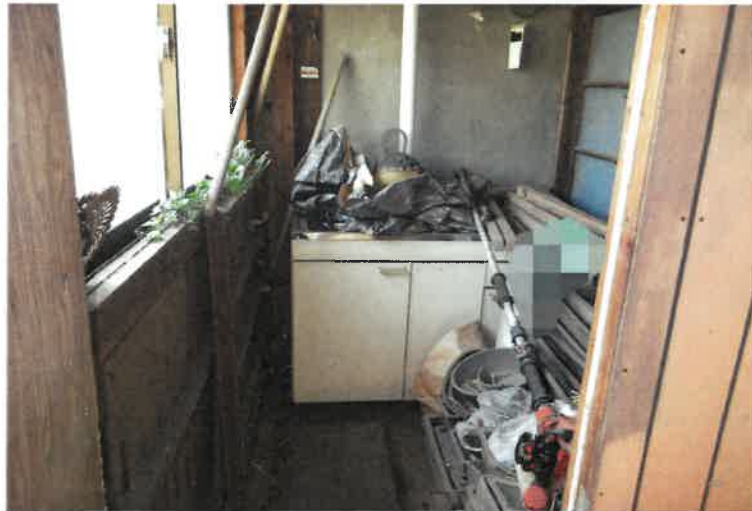
写真11 物件4 附属建物・南西側物入（未登記増築部分）
