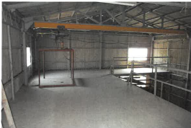
写真13 物件5建物・2階倉庫
