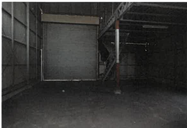
写真12 物件5 建物・1階倉庫
