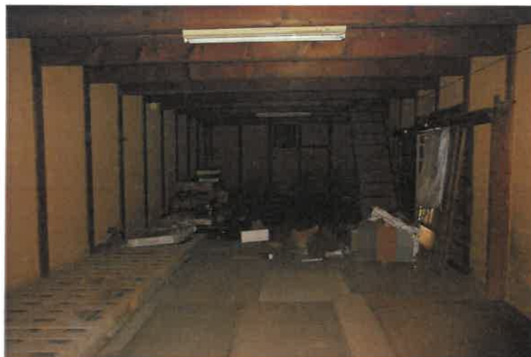
写真7 物件4主建物・1階倉庫
