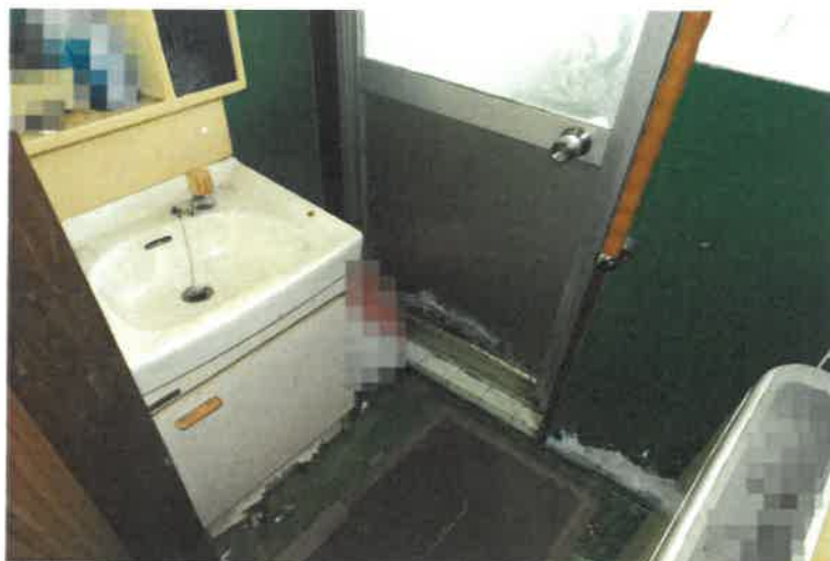
写真10 主である建物内の状況
