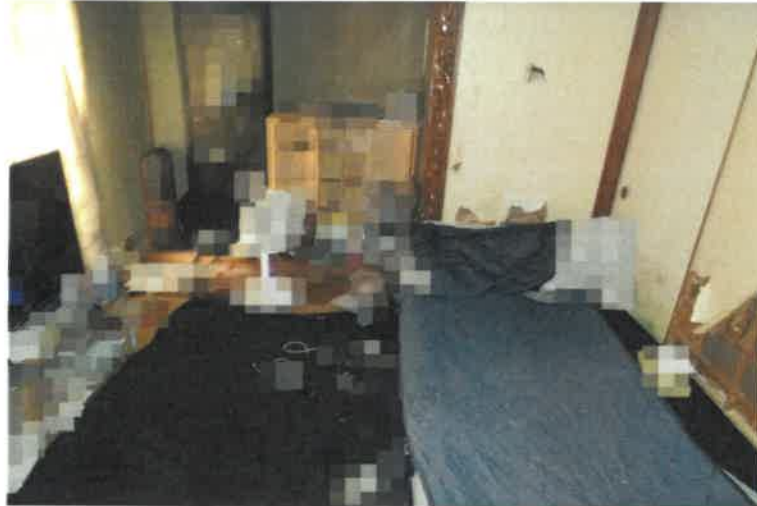
写真7 主である建物内の状況
