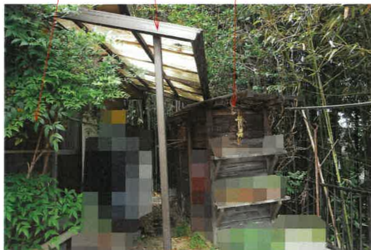
写真3 物件5主建物 下屋 仮設物置
