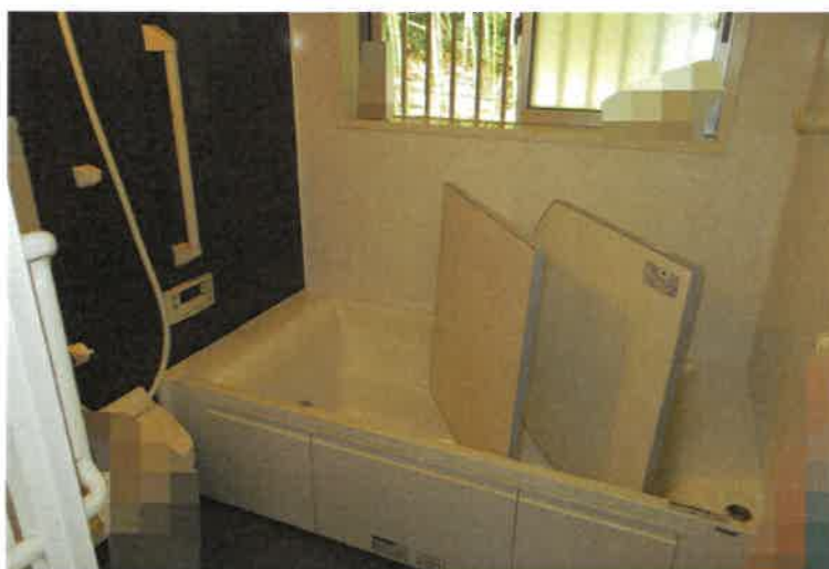
写真11 主建物・1階浴室（増築部分）
