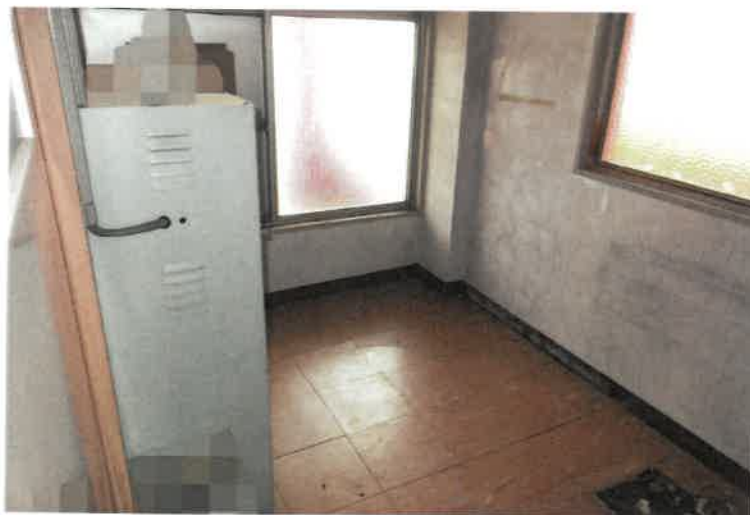
写真 9 4 物件 4 建物・1 階倉庫 1
