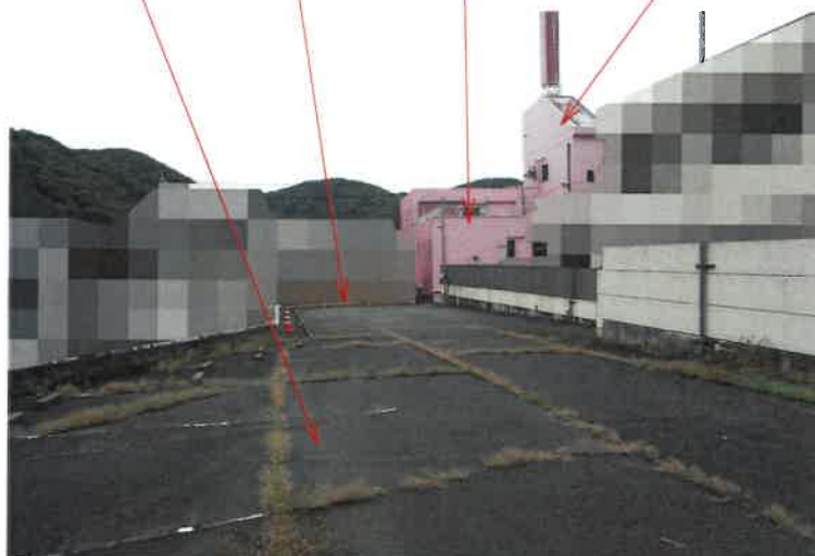
写真 8 物件 5 土地 市道 物件 4 建物 物件 2 主建物
