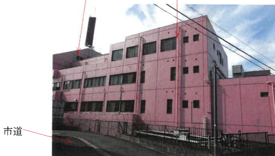
写真3 物件4 建物 物件2 主建物
