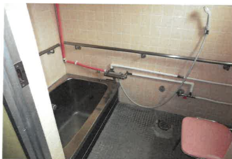
写真 5 6 物件 2 主建物・3 階浴室
