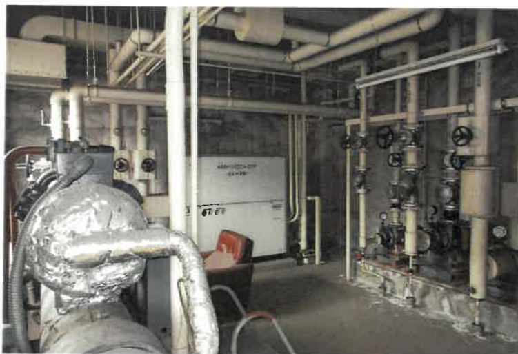
写真4 0 物件2主建物・2階機械室
