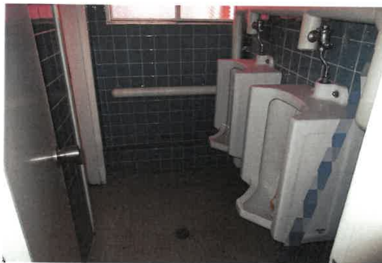
写真 8 7 物件 4 建物・1 階男性用トイレ
