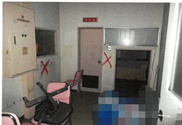
写真 3 0 物件 2 主建物・1 階倉庫 5
