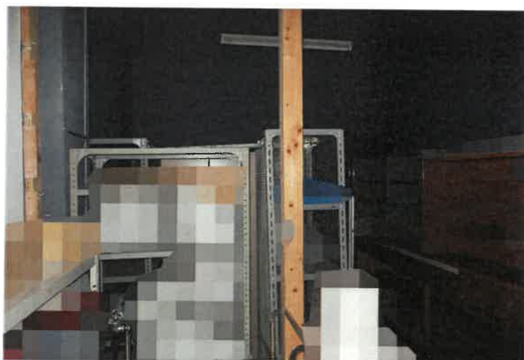
写真 9 5 物件 4 建物・1 階倉庫 2
