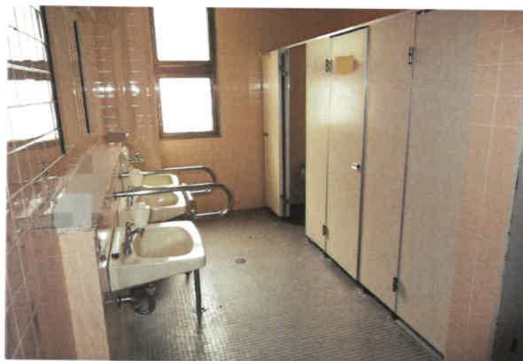
写真 5 7 物件 2 主建物・3 階女性用トイレ
