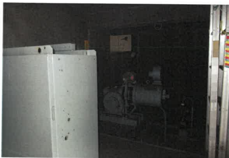
写真 8 0 物件 2 主建物・5 階 E V 機械室
