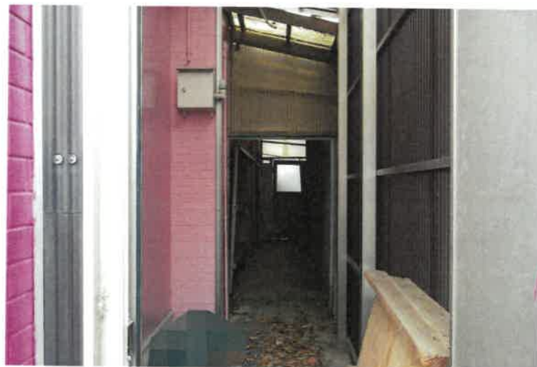
写真 9 8 物件 4 建物・1 階物置（未登記増築部分約 1 2 平方メートル）
