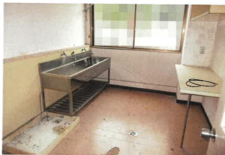
写真 7 2 物件 2 主建物・4 階洗濯室
