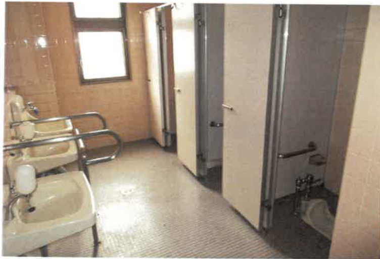
写真 4 3 物件 2 主建物・2 階女性用トイレ
