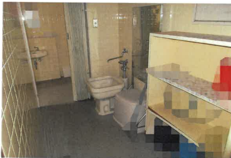
写真 5 8 物件 2 主建物・3 階汚物処理室
