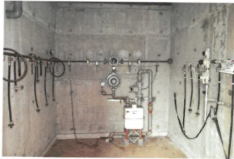
写真 8 2 物件 2 附属建物・倉庫 1
