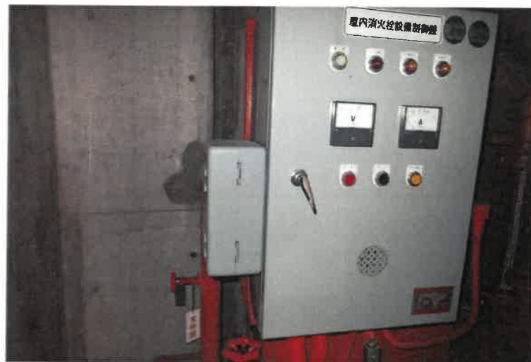
写真 2 3 物件 2 主建物・1 階倉庫 1
