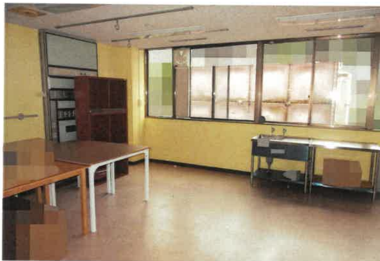
写真48 物件2主建物・2階食堂（215）
