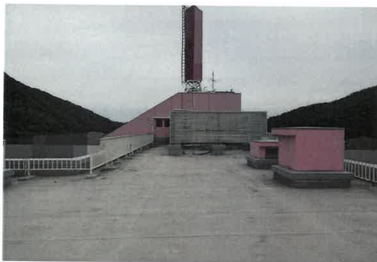
写真 8 1 物件 2 主建物・5 階屋上
