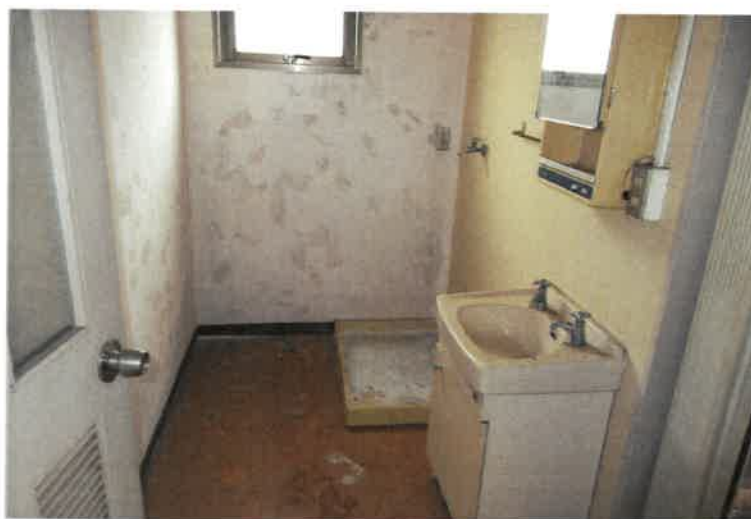
写真 6 6 物件 2 主建物・4 階洗面所
