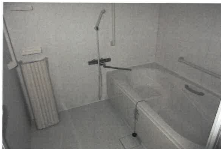
写真 1 8 物件 2 主建物・1 階浴室 2
