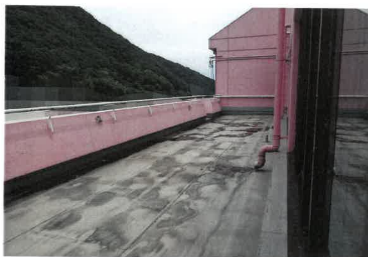
写真 7 5 物件 2 主建物・4 階屋上
