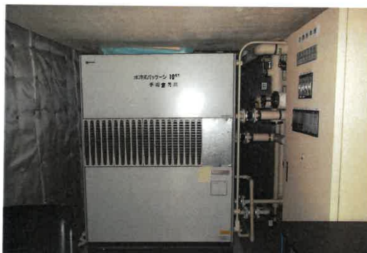
写真 7 4 物件 2 主建物・4 階機械室
