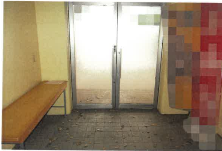
写真 8 5 物件 4 建物・1 階玄関
