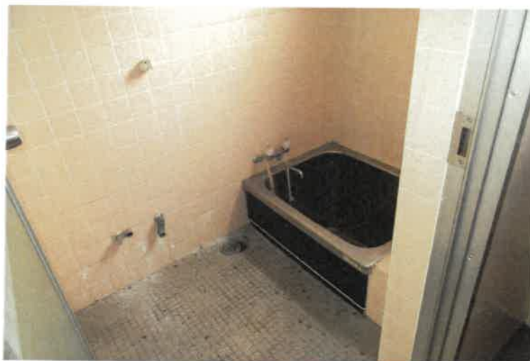
写真 6 7 物件 2 主建物・4 階浴室
