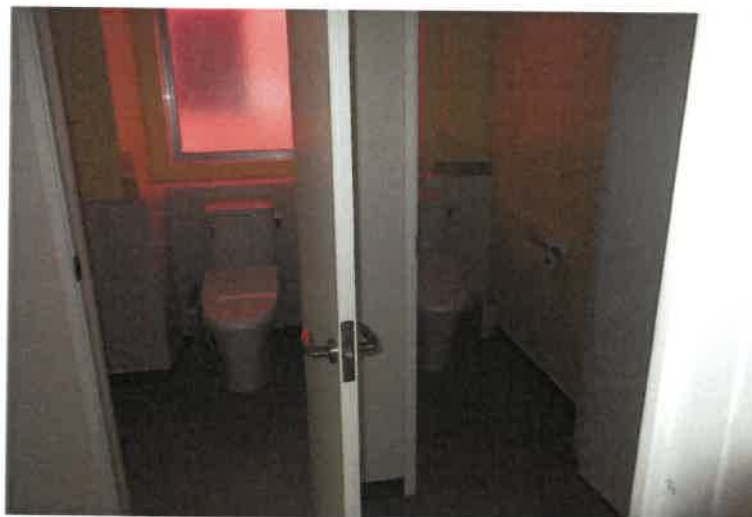
写真 8 6 物件 4 建物・1 階洋式トイレ
