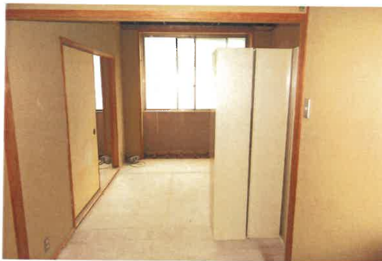
写真 7 0 物件 2 主建物・4 階寮室 2
