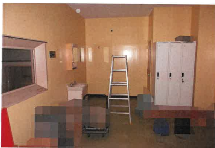
写真 3 2 物件 2 主建物・1 階女子更衣室 2
