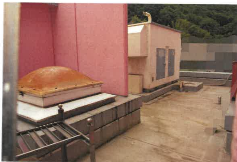
写真5 3 物件2主建物・3階機械室
