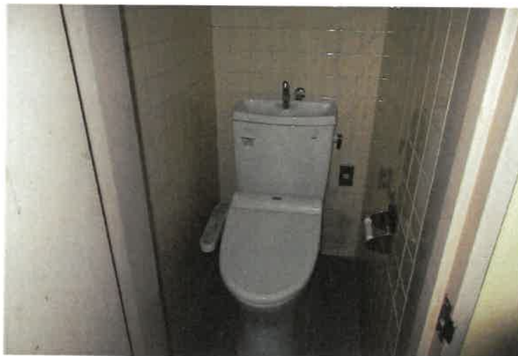
写真 3 3 物件 2 主建物・1 階女子更衣室 2（トイレ部分）
