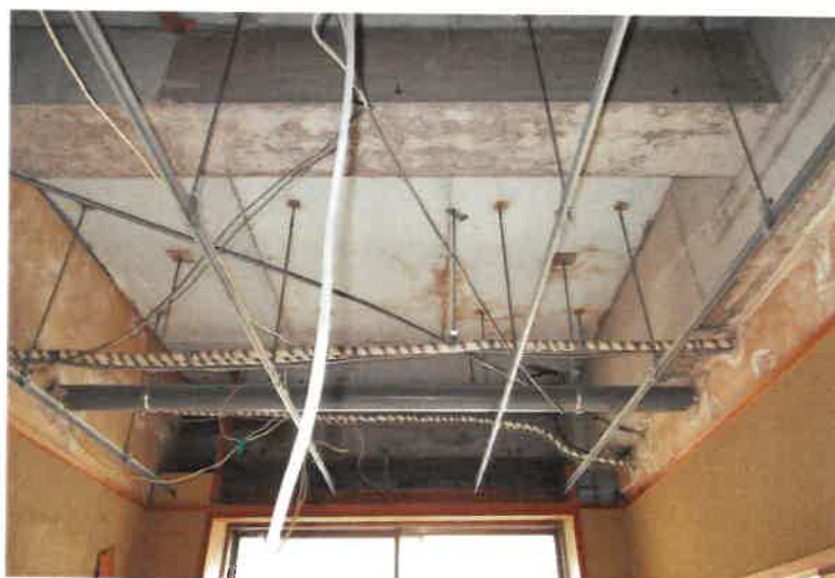
写真 6 9 物件 2 主建物・4 階寮室 1 天井部分 (寮室 3 ～ 5 は同型)
