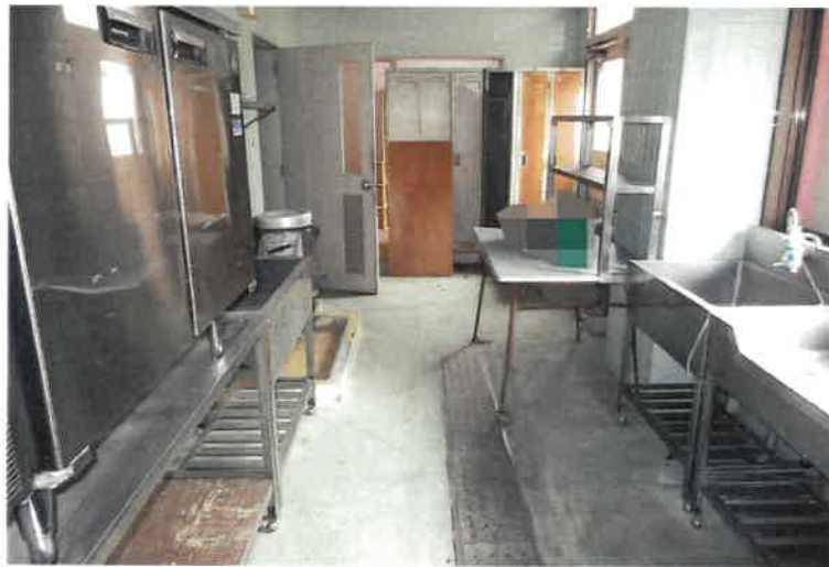
写真 2 0 物件 2 主建物・1 階厨房 2
