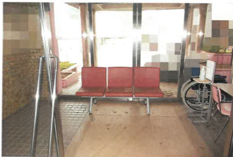
写真10 物件2主建物・1階風除室
