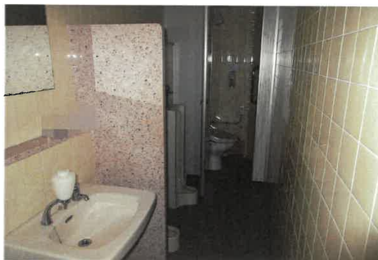
写真 1 5 物件 2 主建物・1 階東側男性用トイレ
