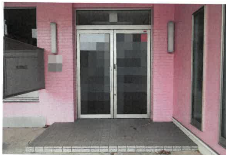
写真 8 4 物件 4 建物・1 階ポーチ
