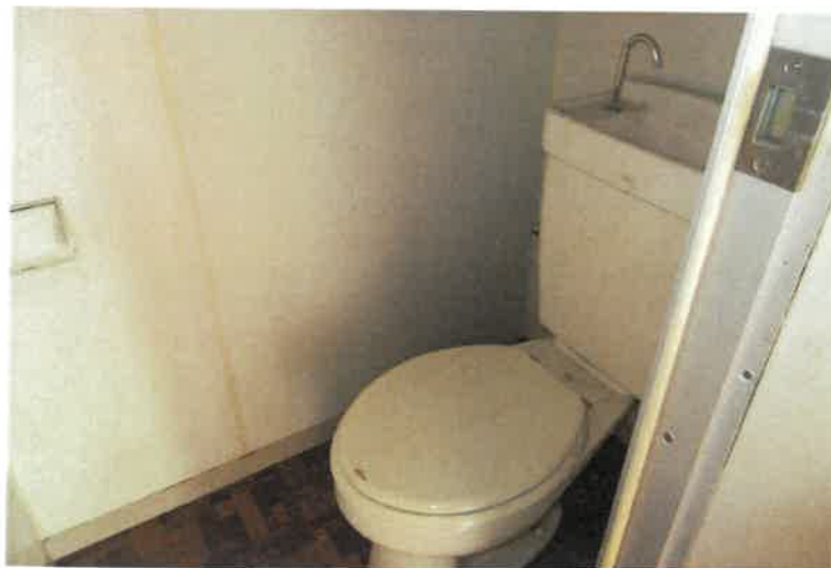
写真 7 3 物件 2 主建物・4 階洗濯室横トイレ
