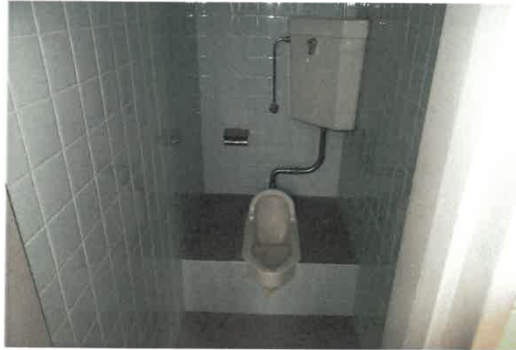
写真 2 2 物件 2 主建物・1 階休憩室横トイレ
