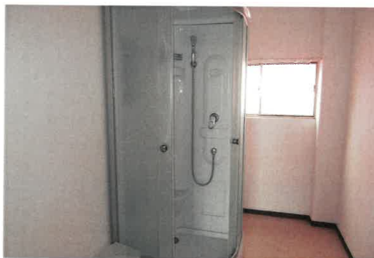
写真 1 2 0 物件 4 建物・3 階シャワー室
