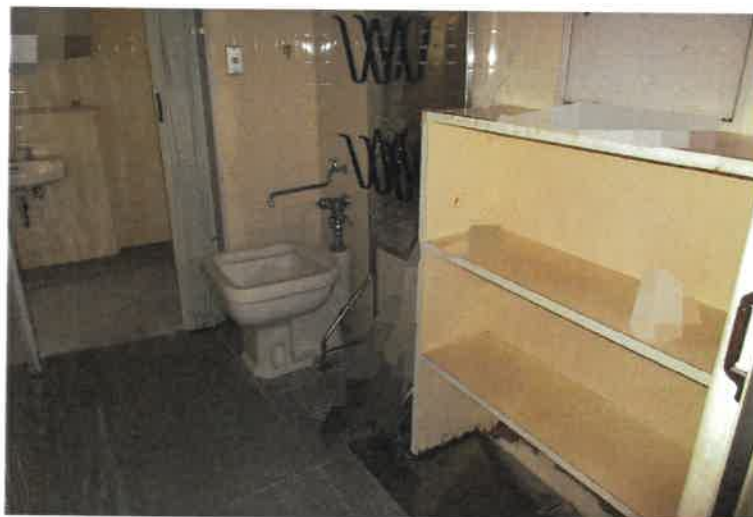
写真 4 4 物件 2 主建物・2 階汚物処理室
