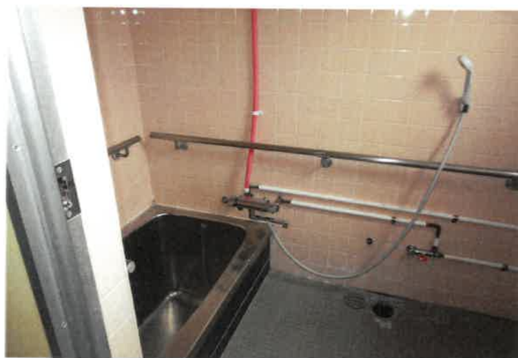
写真4 2 物件2主建物・2階浴室
