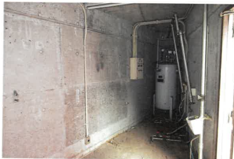
写真 8 3 物件 2 附属建物・倉庫 2
