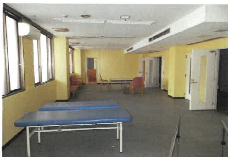
写真 1 4 物件 2 主建物・1 階デイサービス
