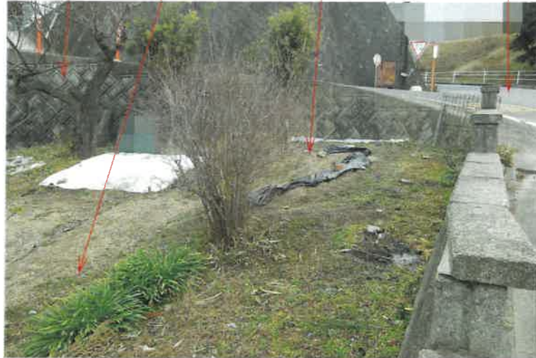
写真 1 0 擁壁 物件 1 土地 件外土地 1 (116-10) 市道
