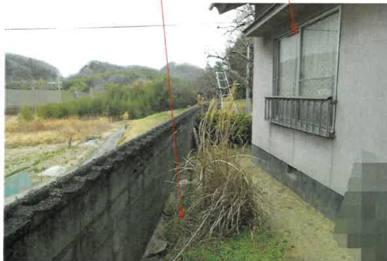
写真 1 1 件外土地 2 (149-3) 物件 2 建物
