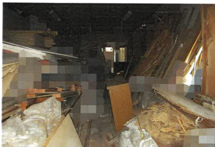
写真5 物件2 主建物・1階倉庫
