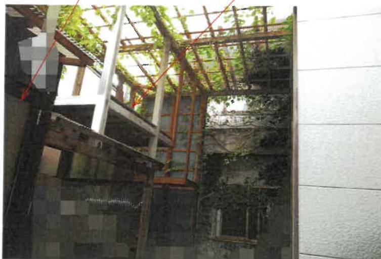
写真4 物件2 未登記附属建物 下屋状物置
