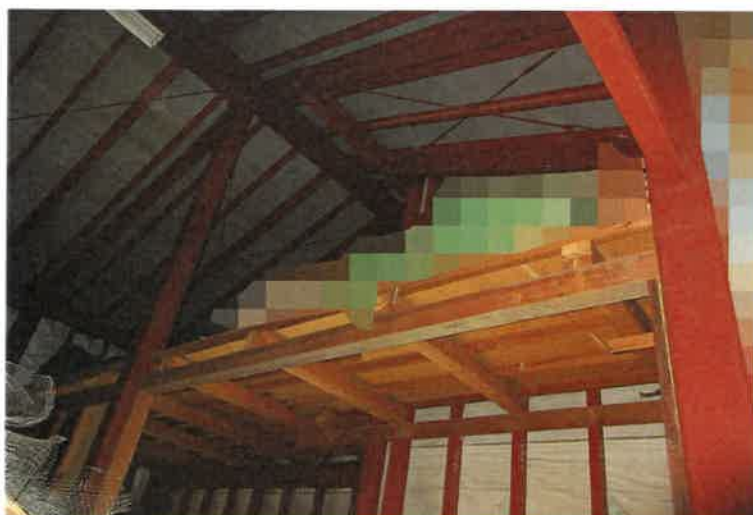
写真8 物件2主建物・2階屋根裏収納
