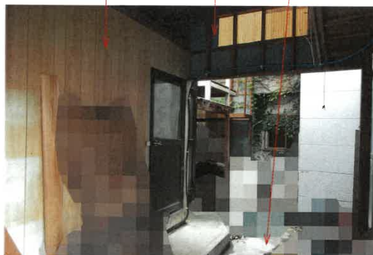
写真3 物件2未登記附属建物 下屋 物件1土地
