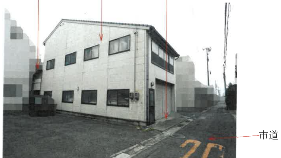
写真1 下屋 物件2主建物 物件1土地
