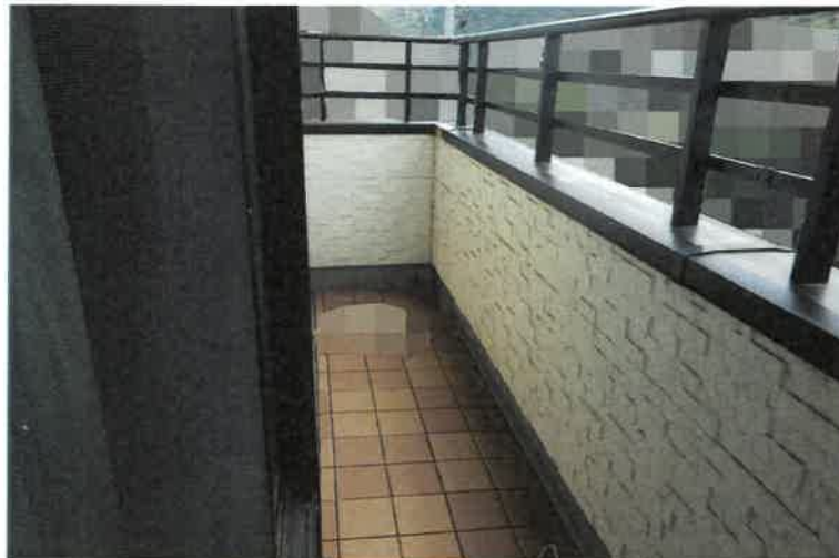
写真20 2階バルコニー
