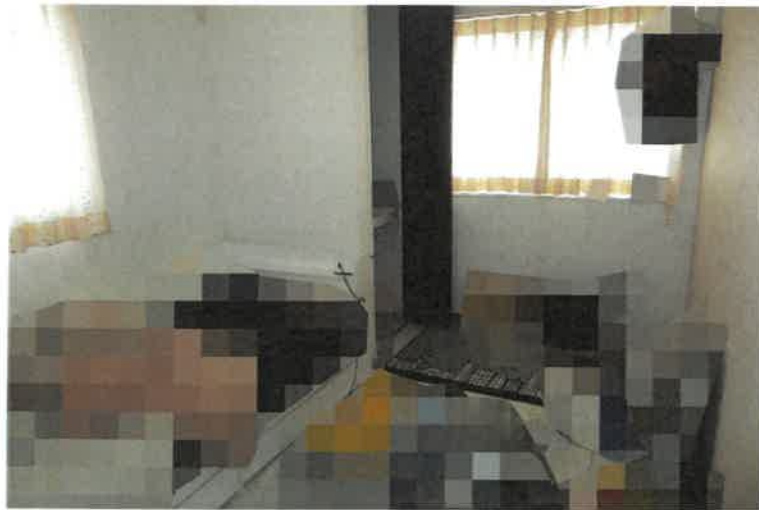
写真 1 6 2階北東側洋室
