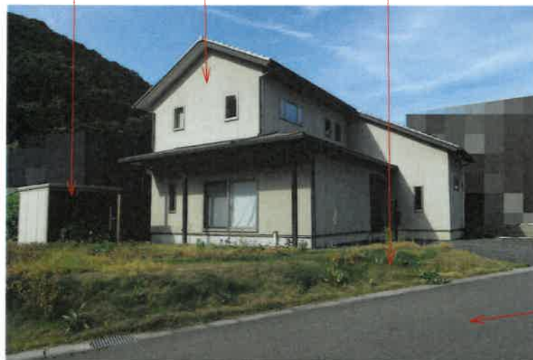
写真2 簡易物置 物件2 建物 物件1 土地
