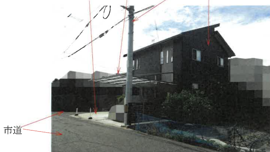
写真1 物件1 土地 カポート 電柱 物件2 建物
