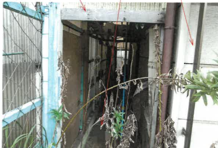
写真6 下屋 物件1 土地 物件2 建物（未登記増築部分）
