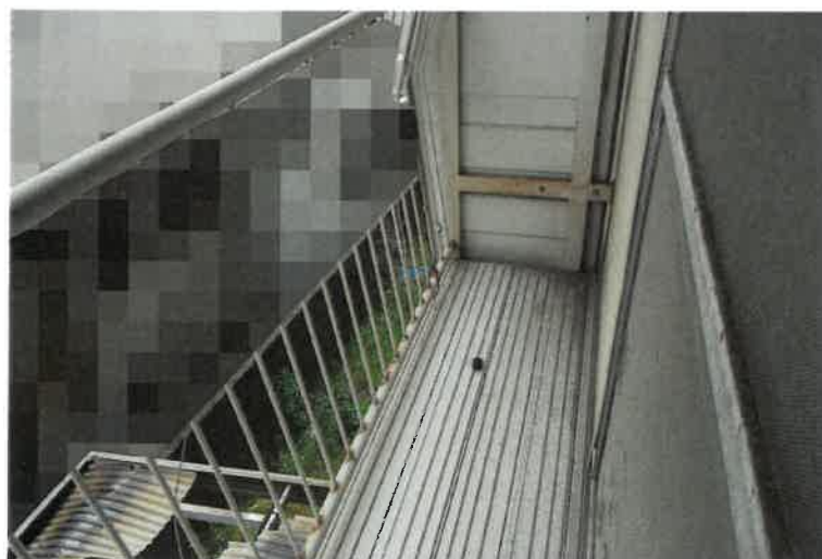
写真 1 8 2 階バルコニー
