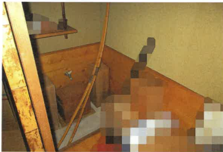
写真11 1階和室側物入
