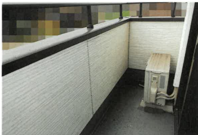
写真 1 5 2 階バルコニー
