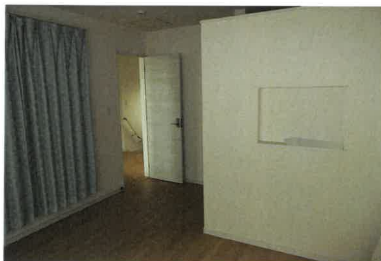
写真 1 5 2 階南東側洋室
