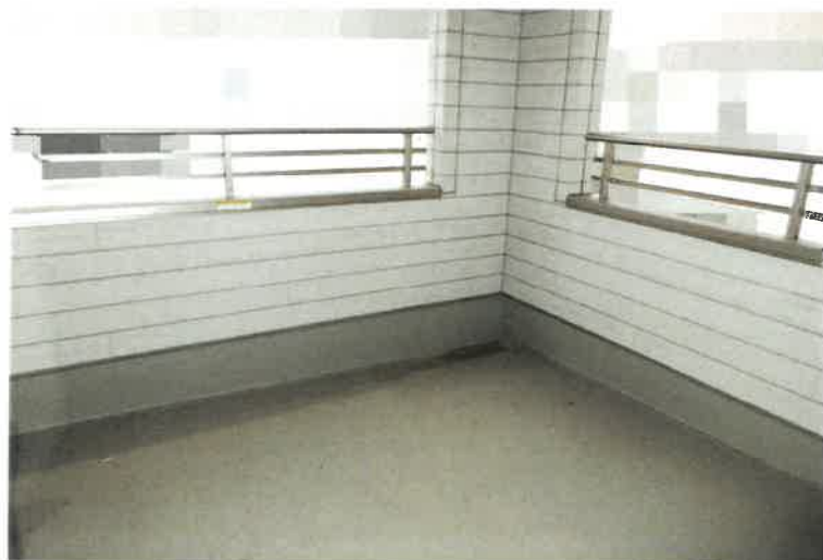
写真18 2階バルコニー
