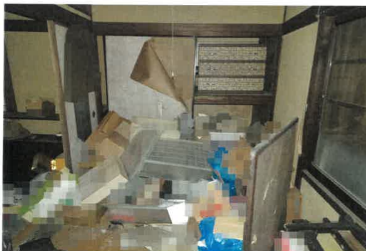
写真 3 6 物件 4 の建物内の状況
