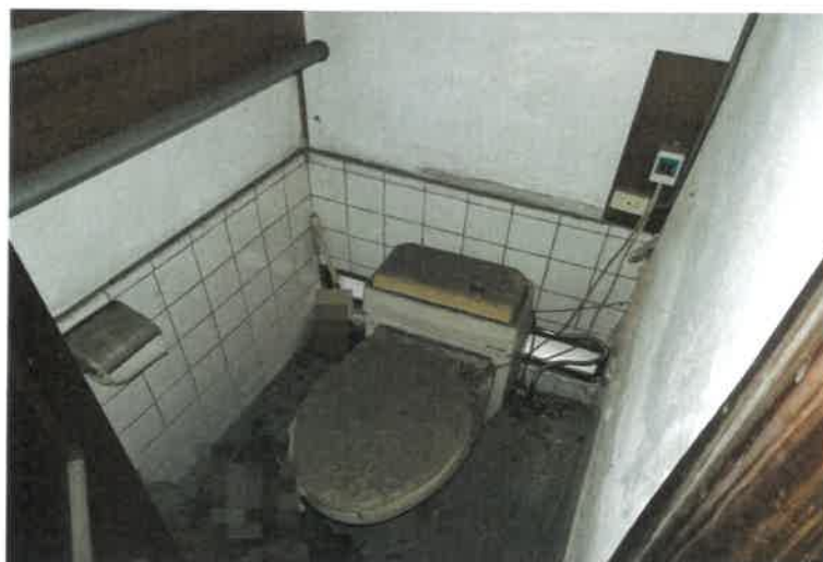
写真 3 0 物件 4 の建物内の状況
