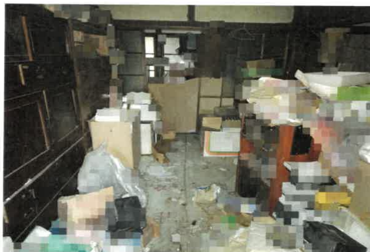
写真 1 5 物件 3 の建物内の状況
