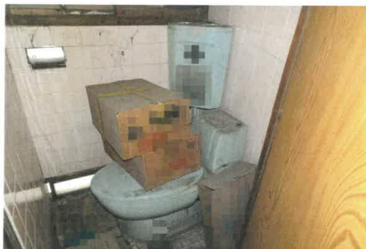
写真１２ 物件３の建物内の状況
