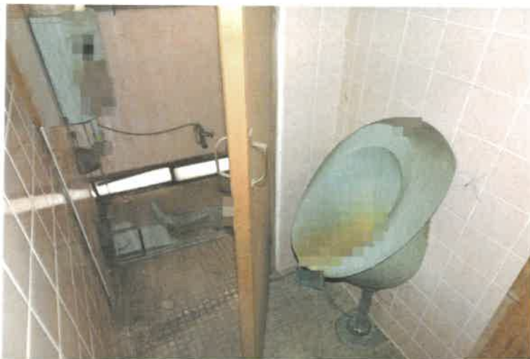
写真 1 3 物件 3 の建物内の状況
