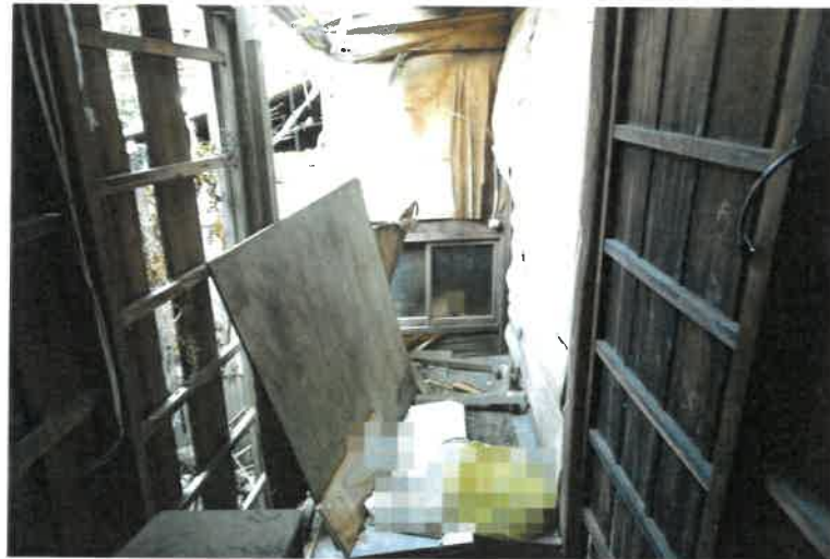
写真 2 6 物件 3, 4 建物間の通路部分の状況
