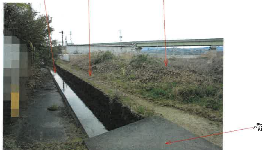
写真5 水路 市道 物件1 土地
