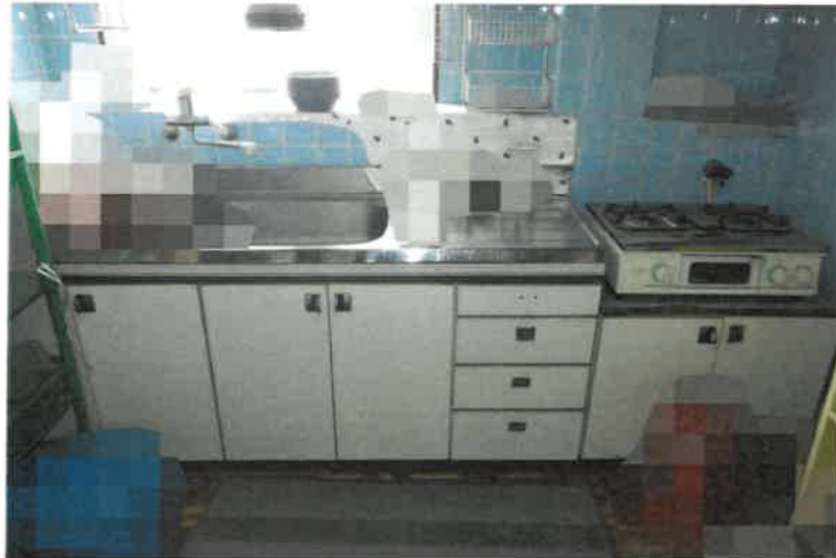
写真16 2階台所（キッチン部分）
