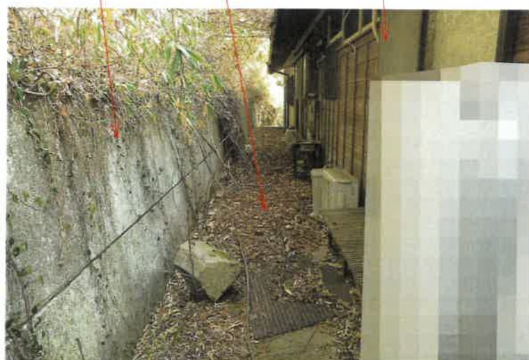
写真6 擁壁 物件1土地 物件3建物
