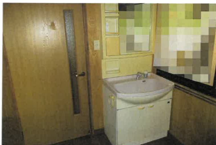
写真 2 3 物件 4 建物・1 階洗面所
