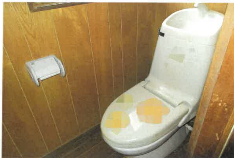
写真 2 2 物件 4 建物・1 階トイレ
