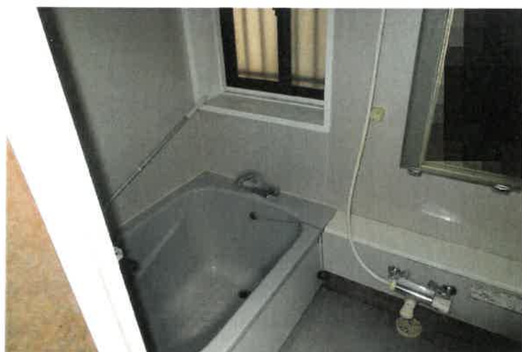
写真 2 4 物件 4 建物・1 階浴室
