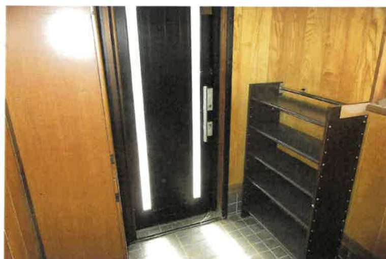
写真 2 1 物件 4 建物・1 階玄関
