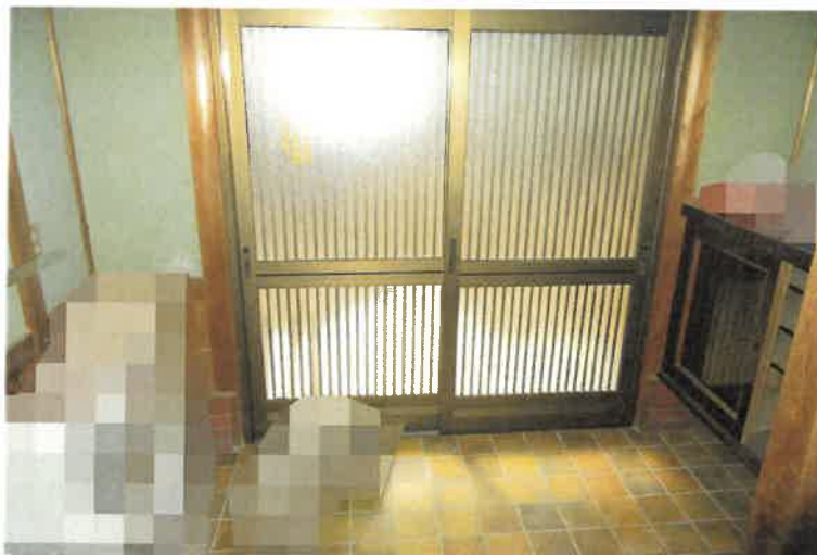
写真7 物件3建物・1階玄関
