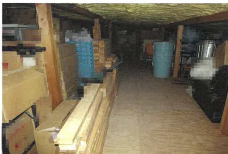
写真 1 7 物件 5 の建物(屋根裏物置)内の状況
