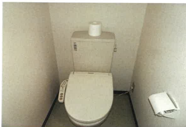
写真 7 2 3 0 7 号室内の状況
