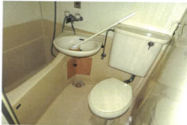
写真 2 3 2 0 5 号室内の状況
