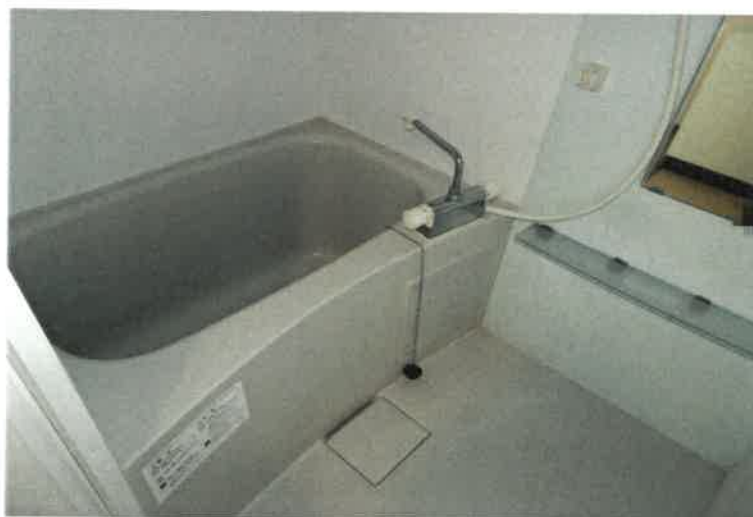
写真 5 1 3 0 1 号室内の状況
