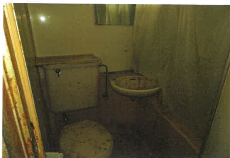
写真48 215号室内の状況
