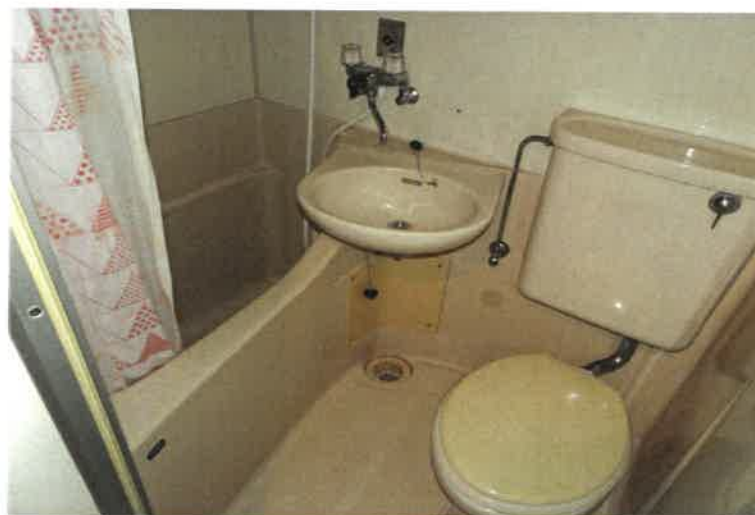
写真 4 2 2 1 2 号室内の状況
