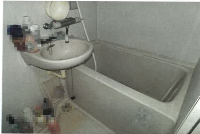
写真19 203号室内の状況
