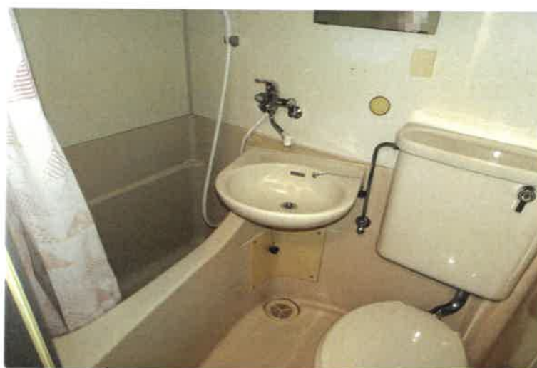
写真 3 5 2 1 0 号室内の状況
