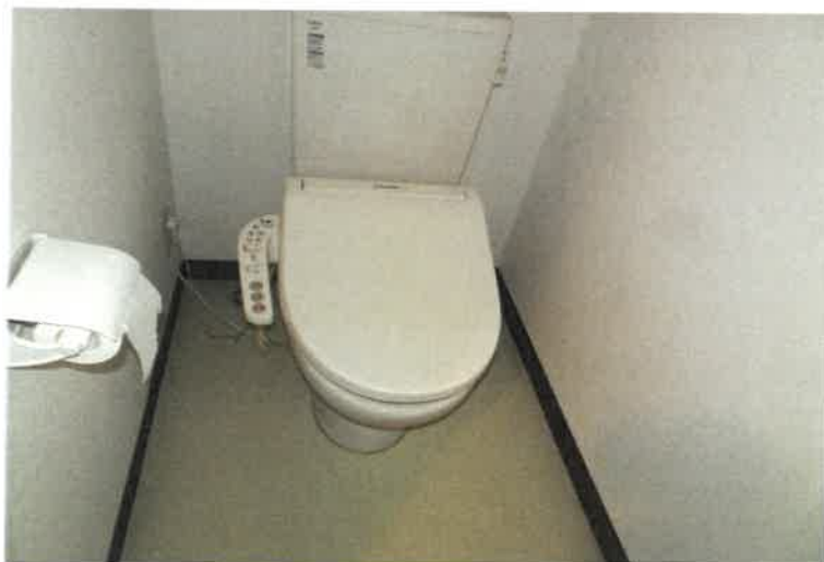
写真 7 9 3 1 0 号室内の状況
