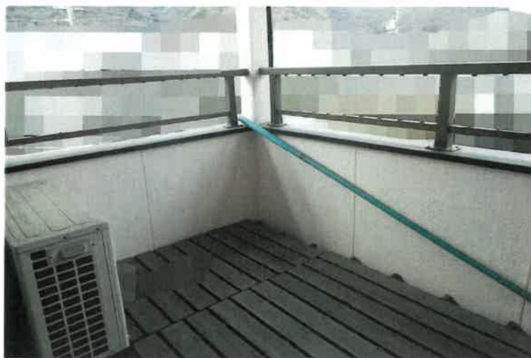
写真 1 8 2階南西側ベランダ
