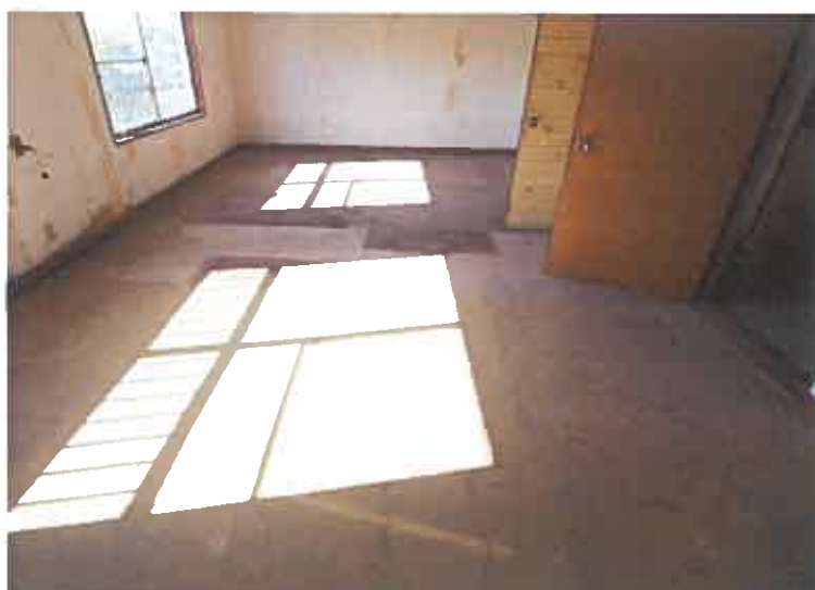
写真9 (主建物2階南側洋室)
