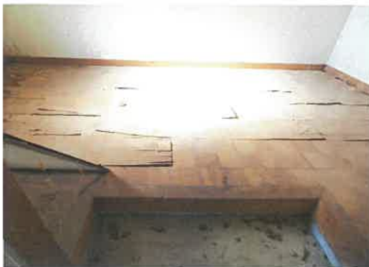
写真 1 2 （符号 2 附属建物西側物置）
