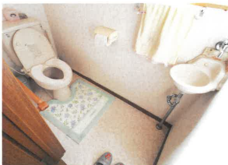
写真9（主建物1階トイレ）
