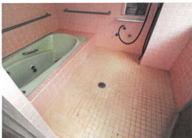
写真 3 0 （ 2 階南西側浴室）
