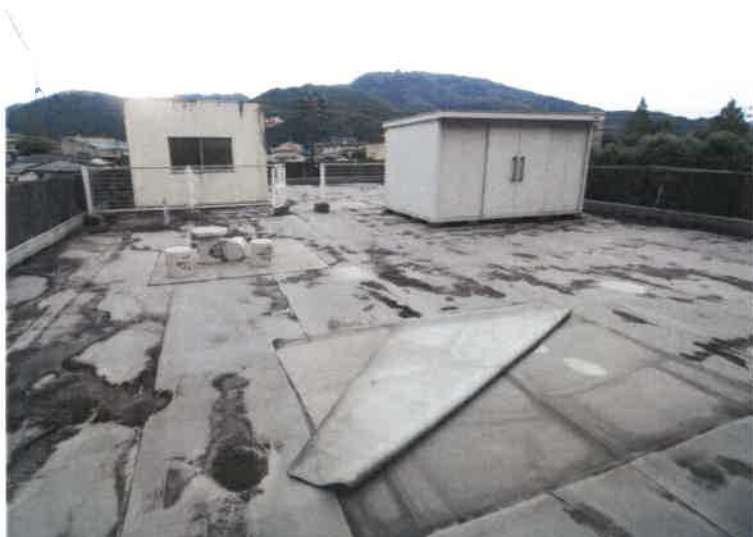
写真 4 5 （3 階南東側屋上）
