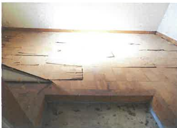
写真 1 2 （符号 2 附属建物西側物置）
