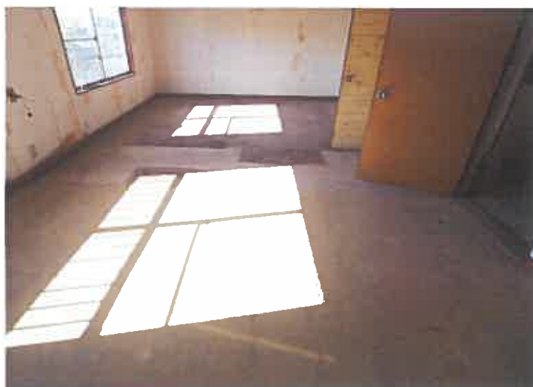
写真9 (主建物2階南側洋室)
