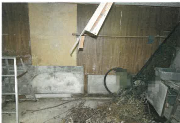
写真 1 2 主である建物内の状況
