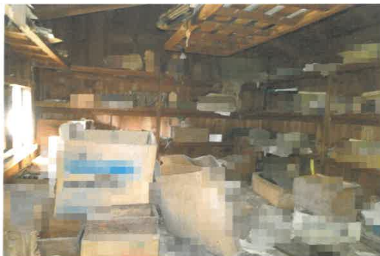
写真 2 2 附属建物符号 3 内の状況
