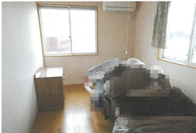
写真 2 3 物件 4 の建物内の状況
