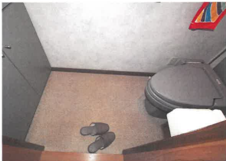
写真9 (2階北側トイレ)
