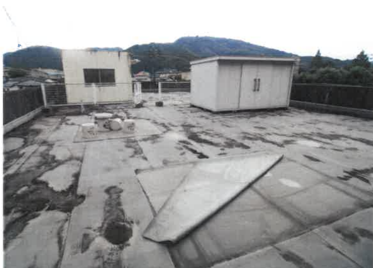
写真 4 5 (3階南東側屋上)
