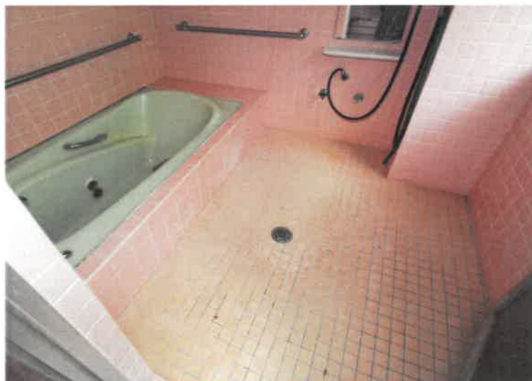
写真 3 0 ( 2 階南西側浴室)
