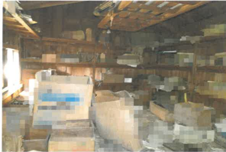
写真 2 2 附属建物符号 3 内の状況
