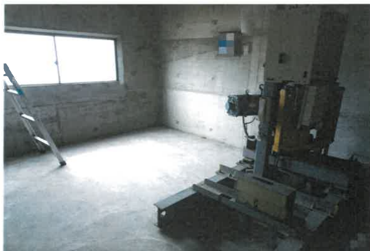
写真185 物件5の建物6階内の状況
