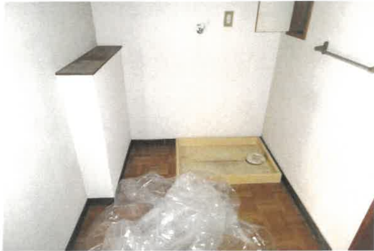
写真 4 3 物件 5 の建物 2 階 1 0 3 号室内の状況
