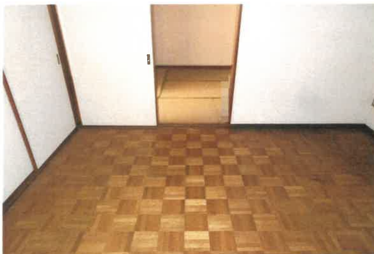
写真131 物件5の建物4階303号室内の状況
