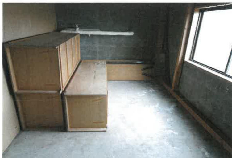
写真186 物件5の建物6階内の状況
