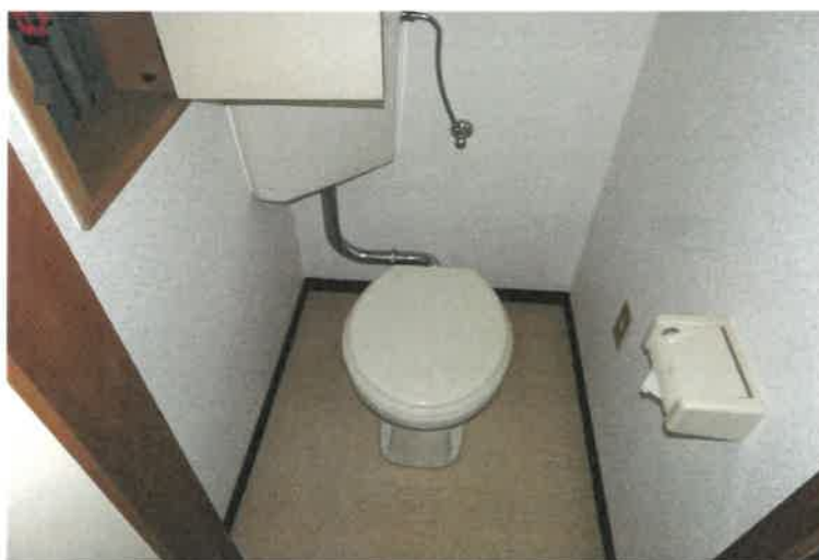
写真 9 8 物件 5 の建物 3 階 2 0 6 号室内の状況
