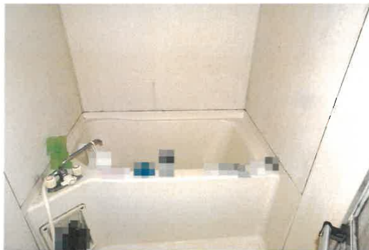
写真 6 2 物件 5 の建物 2 階 1 0 8 号室内の状況
