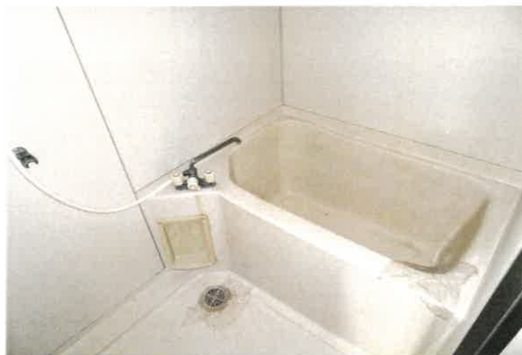
写真159 物件5の建物5階501号室内の状況
