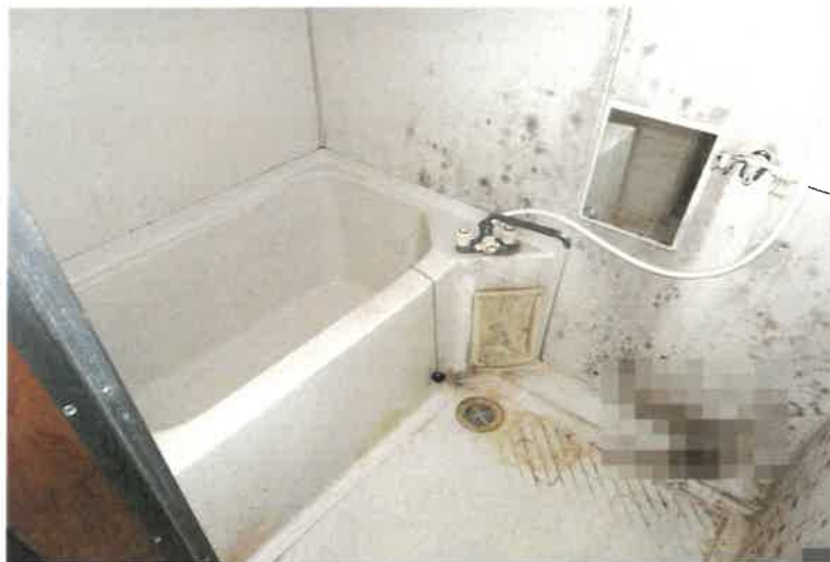
写真 4 4 物件 5 の建物 2 階 1 0 3 号室内の状況
