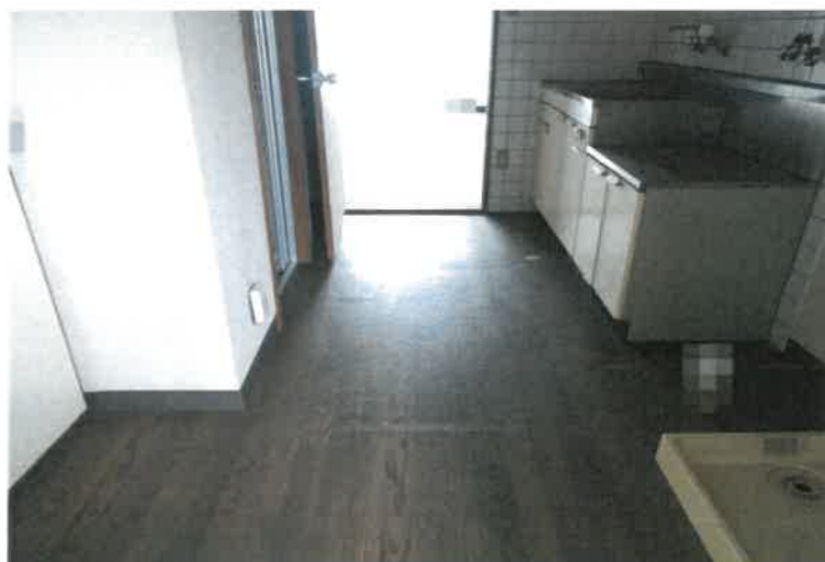
写真 1 5 0 物件 5 の建物 4 階 3 0 8 号室内の状況
