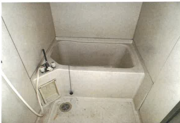
写真１０７ 物件５の建物３階２０８号室内の状況
