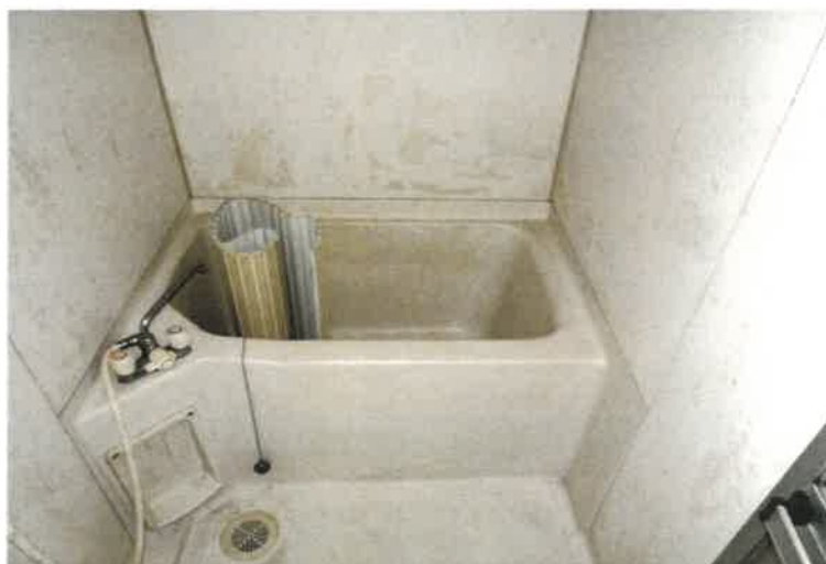
写真 1 4 4 物件 5 の建物 4 階 3 0 6 号室内の状況
