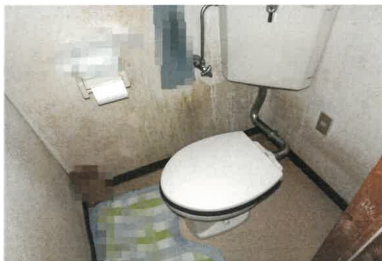
写真 8 7 物件 5 の建物 3 階 2 0 3 号室内の状況
