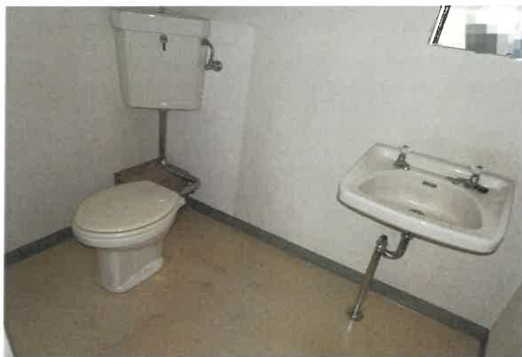
写真 3 7 物件 5 の建物 2 階 1 0 2 号室内の状況
