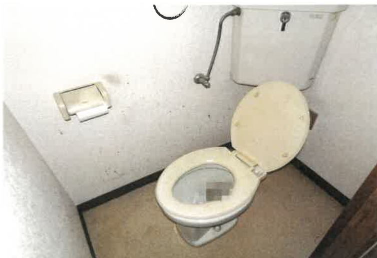
写真 1 3 5 物件 5 の建物 4 階 3 0 3 号室内の状況
