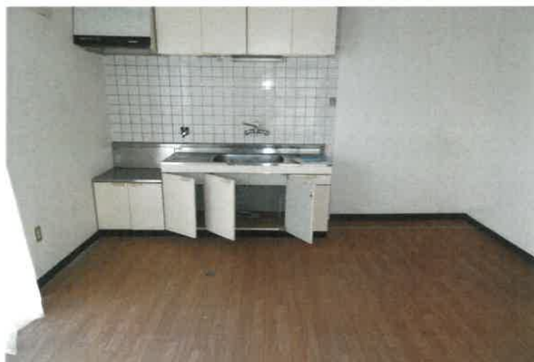
写真168 物件5の建物5階502号室内の状況
