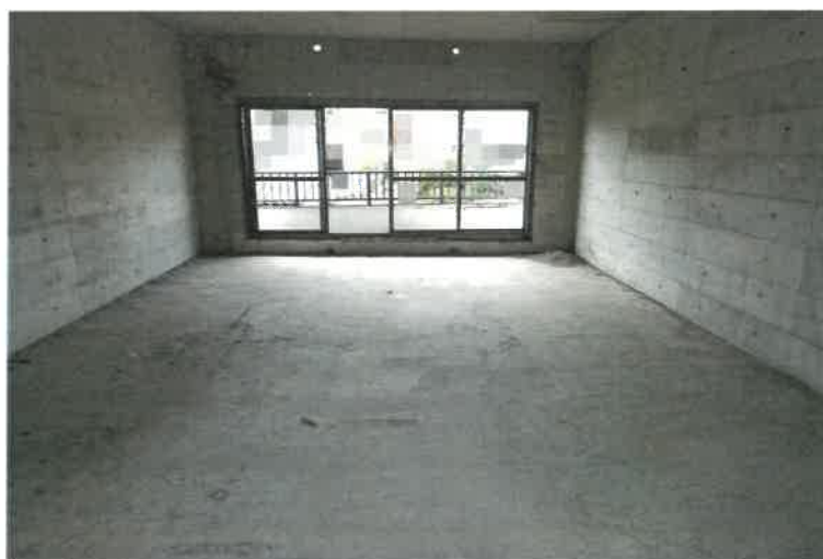
写真 6 8 物件 5 の建物 2 階増築部分の状況
