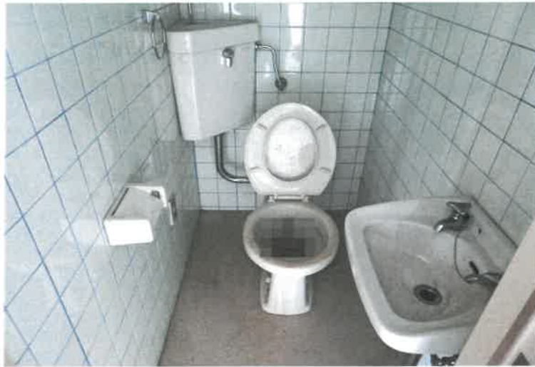
写真3 4 物件5の建物2階101号室内の状況
