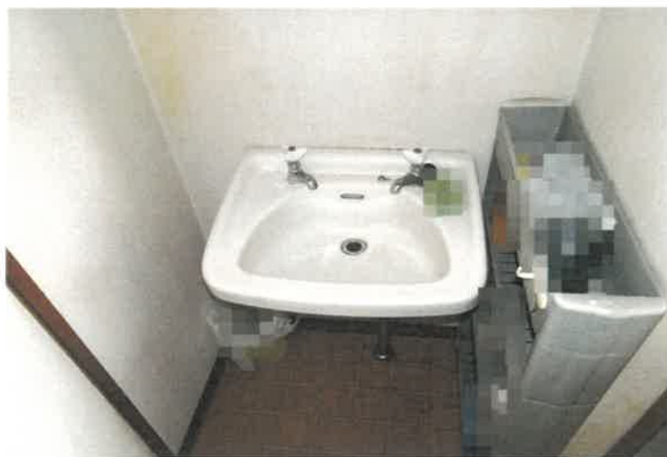
写真 1 1 2 物件 5 の建物 3 階 2 1 0 号室内の状況
