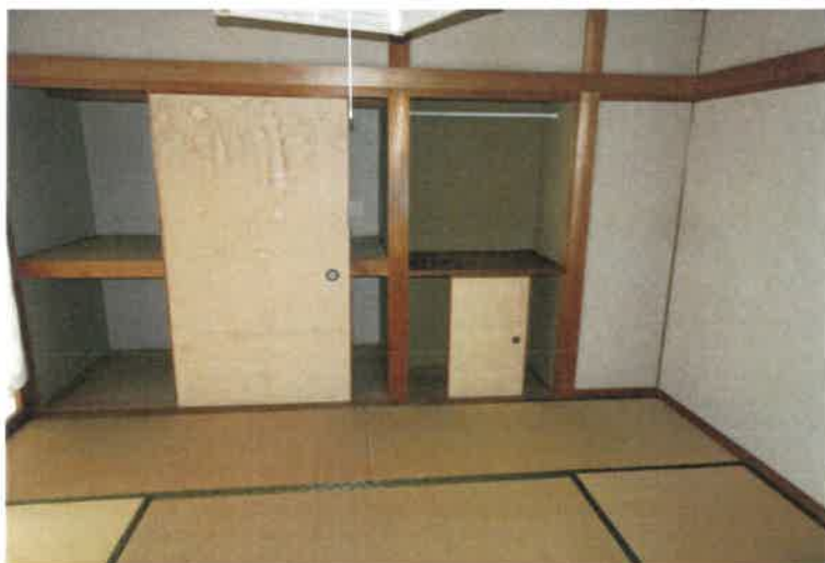
写真 1 7 4 物件 5 の建物 5 階 5 0 3 号室内の状況
