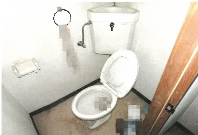
写真 4 5 物件 5 の建物 2 階 1 0 3 号室内の状況
