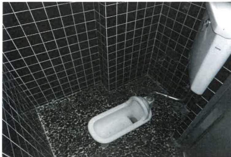
写真8 物件4の建物1階内の状況
