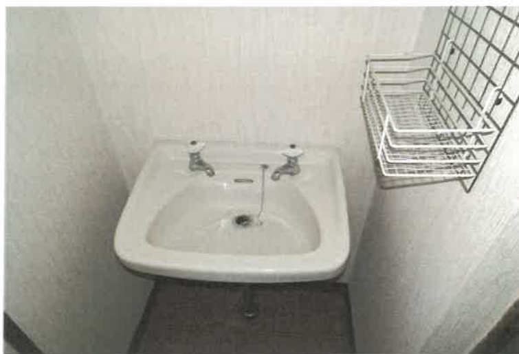
写真58 物件5の建物2階107号室内の状況
