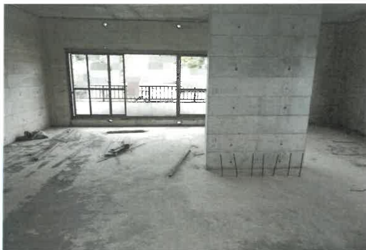
写真 1 1 5 物件 5 の建物 3 階増築部分内の状況
