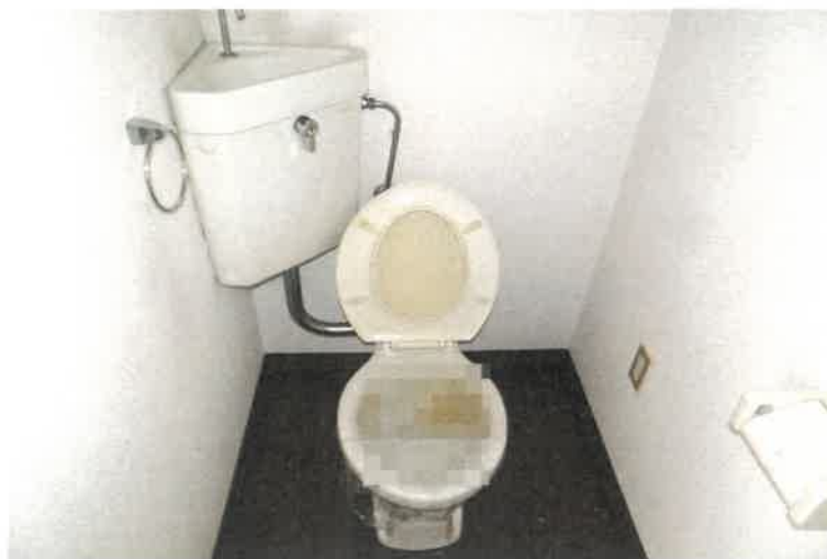
写真160 物件5の建物5階501号室内の状況
