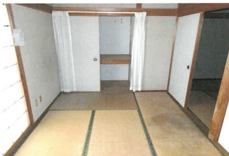
写真41 物件5の建物2階103号室内の状況
