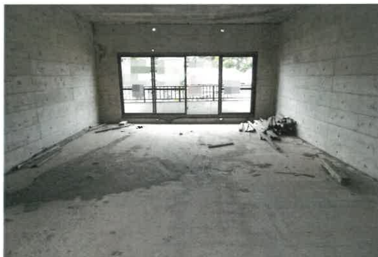
写真 1 1 4 物件 5 の建物 3 階増築部分内の状況
