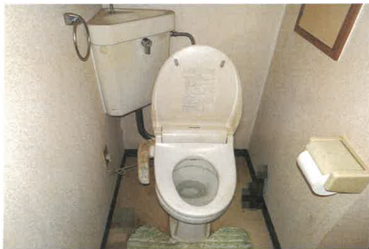
写真 6 5 物件 5 の建物 2 階 1 1 0 号室内の状況
