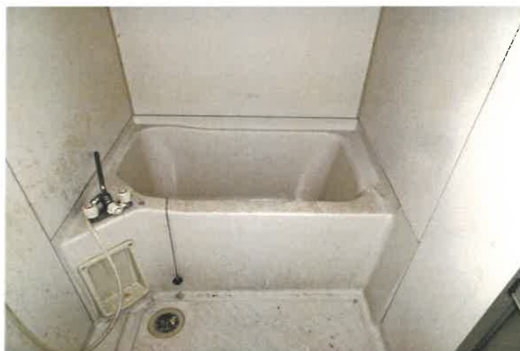
写真152 物件5の建物4階308号室内の状況
