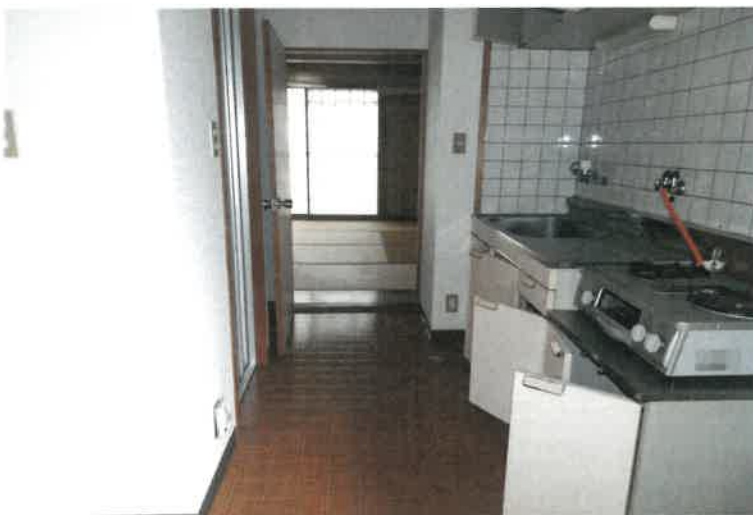
写真105 物件5の建物3階208号室内の状況
