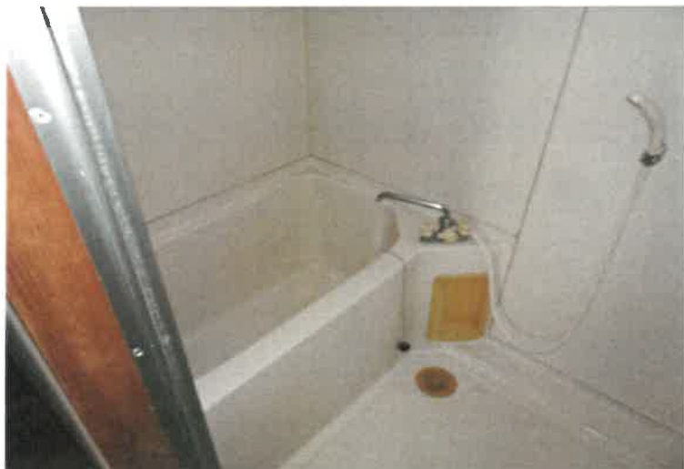
写真 9 3 物件 5 の建物 3 階 2 0 5 号室内の状況
