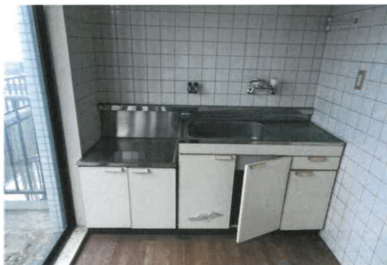
写真3 3 物件5の建物2階101号室内の状況
