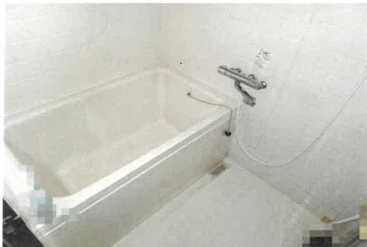
写真 1 7 8 物件 5 の建物 5 階 5 0 3 号室内の状況
