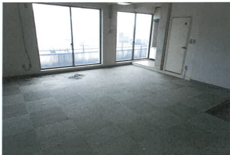
写真3 2 物件5の建物2階101号室内の状況
