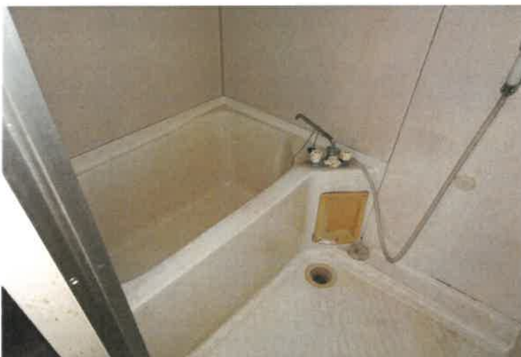
写真 1 3 8 物件 5 の建物 4 階 3 0 5 号室内の状況
