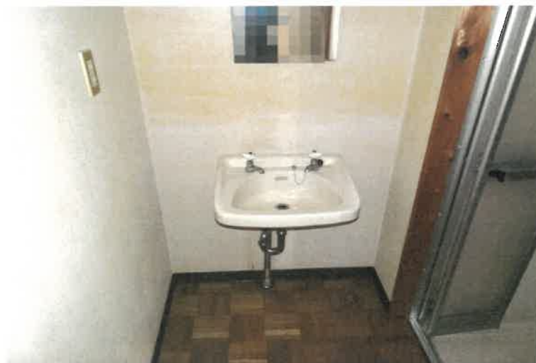
写真167 物件5の建物5階502号室内の状況
