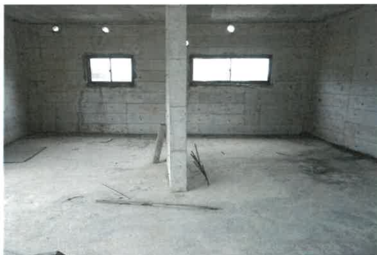
写真 1 1 6 物件 5 の建物 3 階増築部分内の状況
