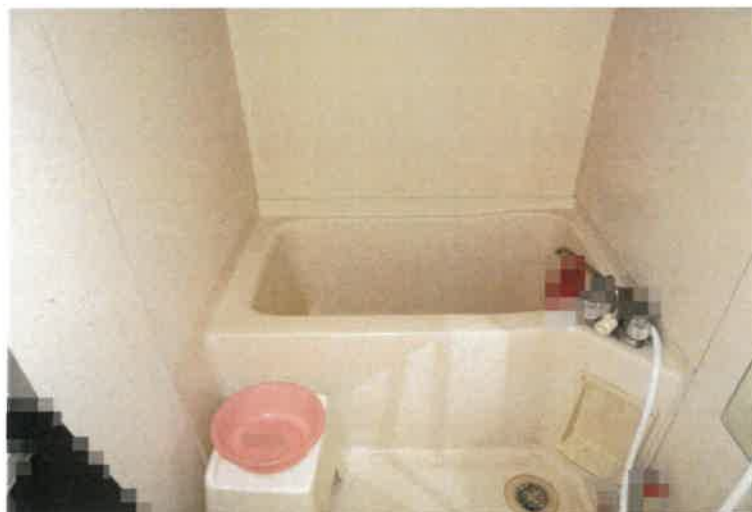
写真 1 1 1 物件 5 の建物 3 階 2 1 0 号室内の状況
