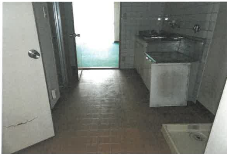
写真 1 4 2 物件 5 の建物 4 階 3 0 6 号室内の状況
