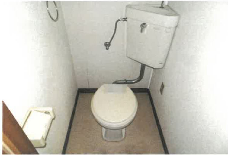
写真 9 4 物件 5 の建物 3 階 2 0 5 号室内の状況
