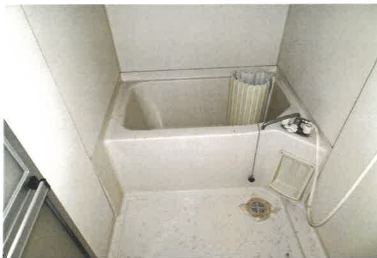
写真103 物件5の建物3階207号室内の状況
