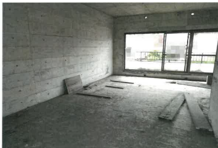
写真 6 9 物件 5 の建物 2 階増築部分の状況
