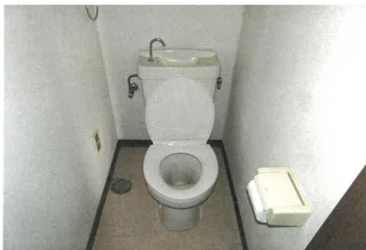
写真 1 7 6 物件 5 の建物 5 階 5 0 3 号室内の状況
