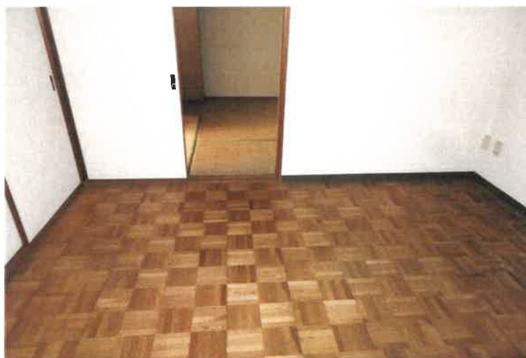
写真 3 9 物件 5 の建物 2 階 1 0 3 号室内の状況
