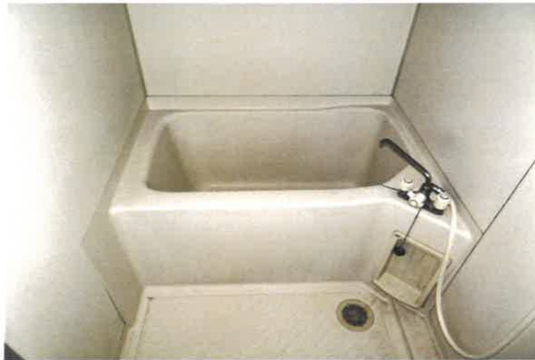
写真166 物件5の建物5階502号室内の状況
