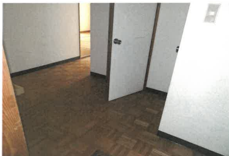
写真164 物件5の建物5階502号室内の状況
