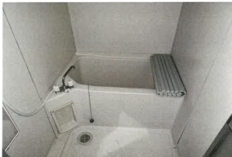
写真 7 8 物件 5 の建物 3 階 2 0 2 号室内の状況
