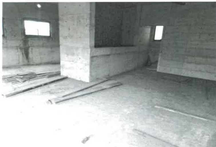
写真 7 0 物件 5 の建物 2 階増築部分の状況
