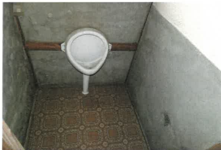
写真8 主である建物内の状況
